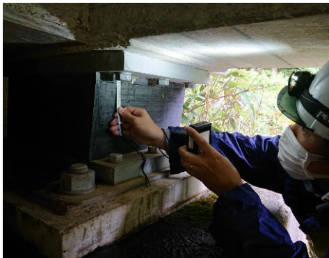
橋梁の被災状況調査(珠洲市)
