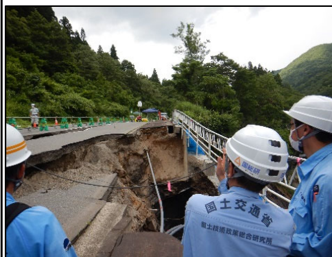
県管理道路の高度技術指導(山形県米沢市)
