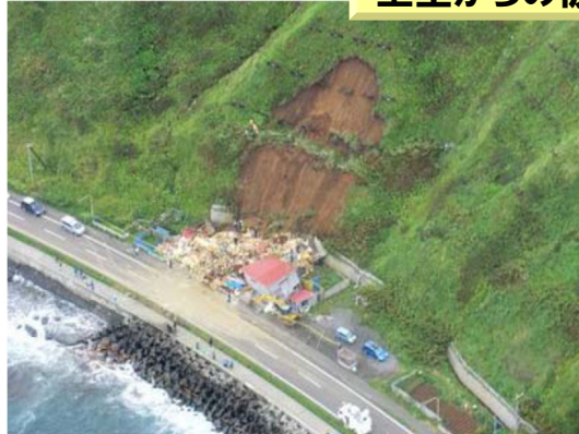
土砂災害により全壊した住宅
