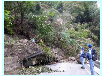
斜面崩壊箇所の調査(岩泉町)
