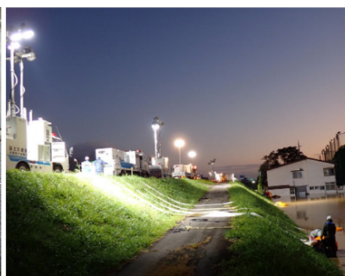
排水ポンプ車による24時間体制の緊急排水 (長野県飯山市)
