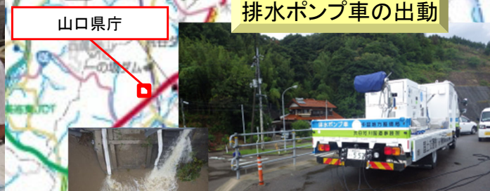
高津川派川南田川水門
