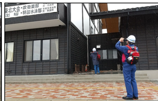
中学校外観被災状況調査(相馬市)
