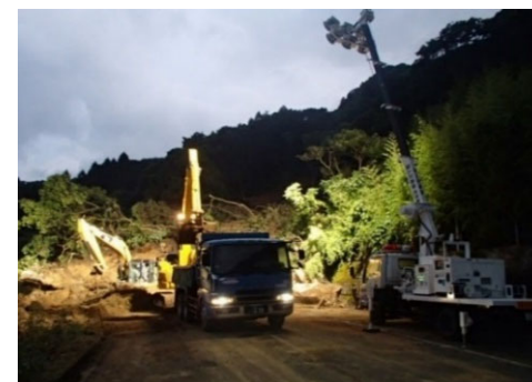
道路啓開夜間作業を照明車が支援 (宮崎県串間市 国道448号)
