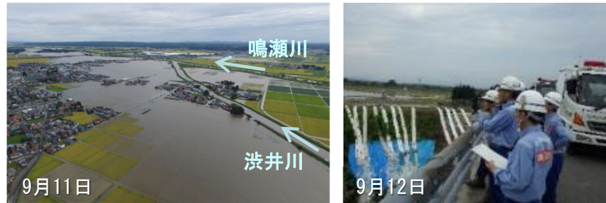
上空からの被災状況調査
