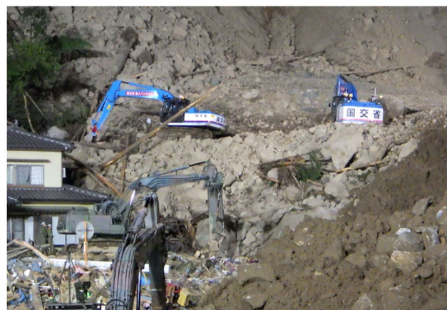
遠隔操作式バックホウによる捜索活動支援
