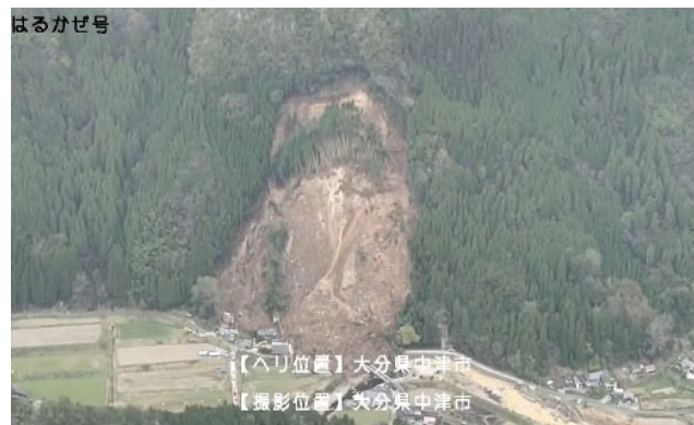
防災ヘリによる被災状況調査
