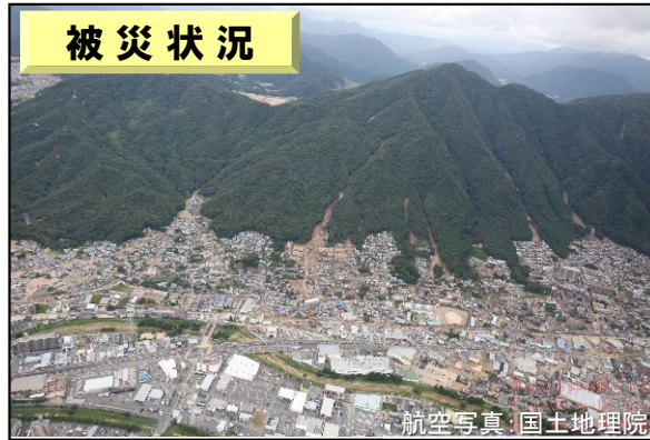
安佐南区と安佐北区の被災状況
