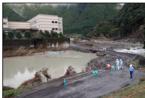
工事用道路施工状況の確認(静岡市)
