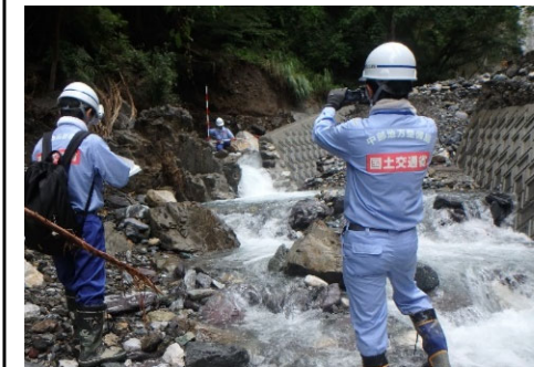
砂防施設の被災状況を調査(熊本県五木村)
