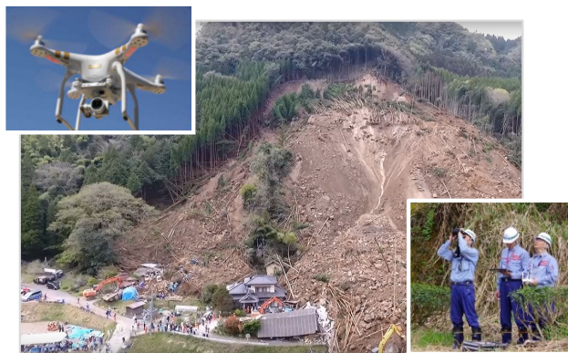
ドローンによる崩落斜面の詳細調査
