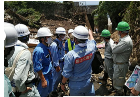
静岡県、協力企業、自衛隊と合同で、道路の被災状況を調査。
