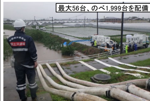
排水活動状況(福岡県久留米市)
