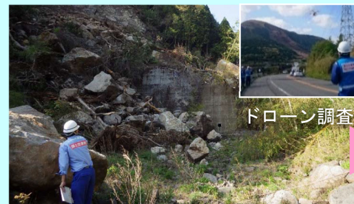
土石流危険溪流の点検
