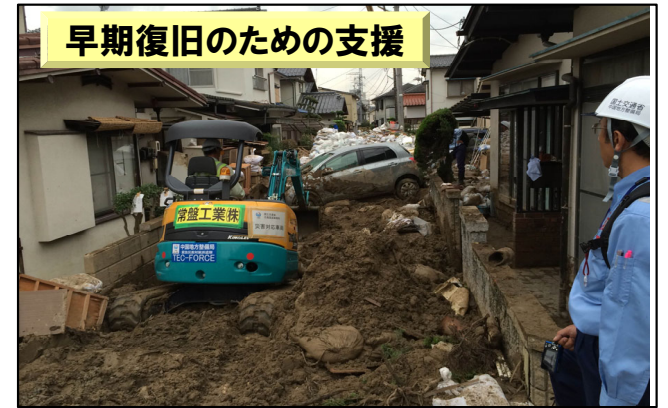
市道等に堆積した土砂を約1ヶ月で撤去
