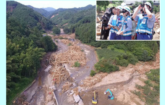
ドローンによる流木調査(朝倉市)
