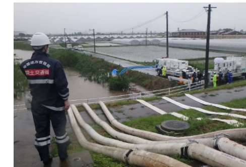
排水活動状況(福岡県久留米市)
