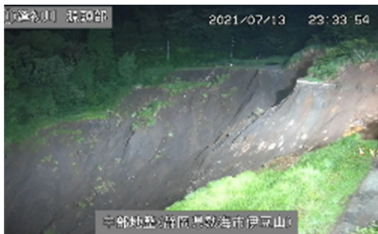
源頭部には、照明車を設置し、夜間でも照度を確保。
