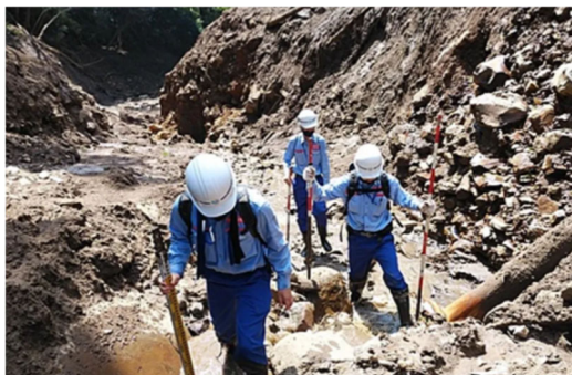
逢初川で発生した土石流による土砂の堆積状況を調査。
