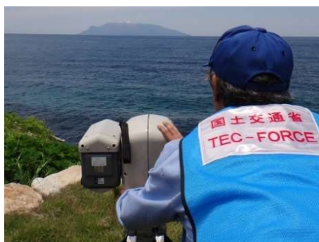
監視カメラの設置
