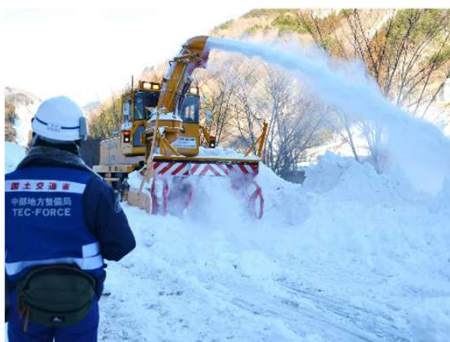
孤立集落解消に向けた 除雪作業
