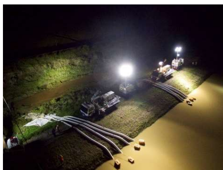
排水ポンプ車による 緊急排水
