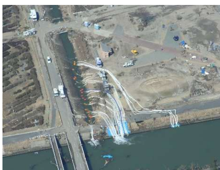
自治体所管施設の 被災状況調査
