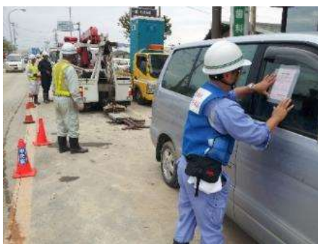
道路啓開に伴う 放置車両の撤去
