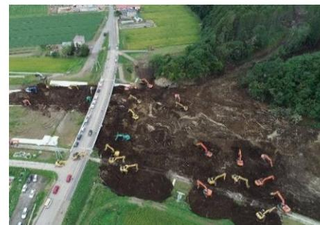
河道閉塞箇所において24時間体制で土砂撤去を実施
