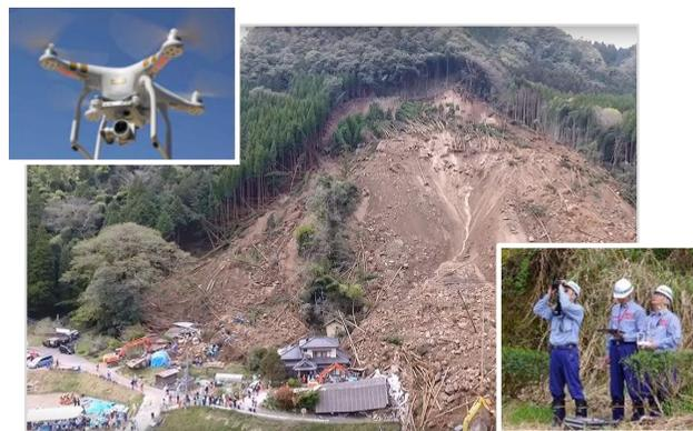
ドローンによる崩落斜面の詳細調査
