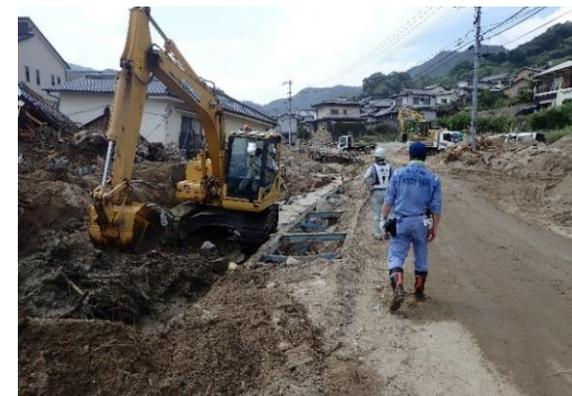
河道閉塞箇所における土砂等の撤去作業
