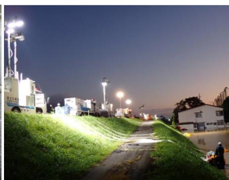
排水ポンプ車による24時間体制の緊急排水
