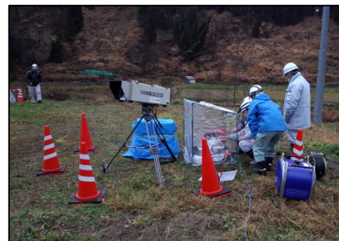
監視カメラによる被災箇所の監視支援
