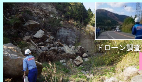
土石流危険溪流の点検
