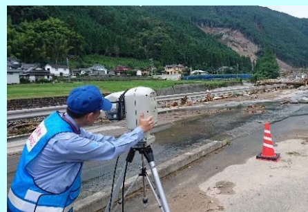
斜面崩壊箇所の調査(日田市)
