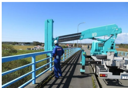
町道橋梁の緊急点検を支援 (北海道勇払郡厚真町)
