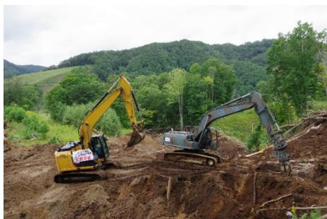
関係機関と連携した道路啓開 (北海道勇払郡 厚真町)
