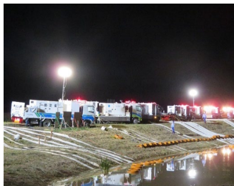
孤立した病院や住宅の早期解消に向け 24時間体制で緊急排水を実施 (佐賀県大町町)
