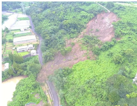
ドローンによるぼた山公園の 土砂崩れ状況調査 (佐賀県大町町)
