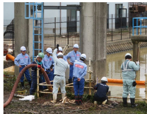
協力企業と連携し流出した 油の除去作業を実施 (佐賀県大町町)
