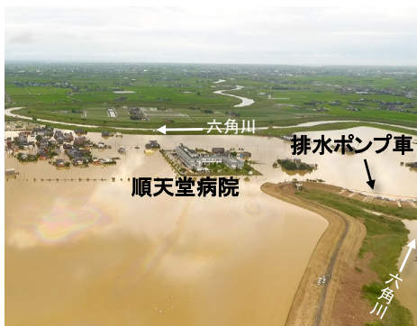
順天堂病院周辺の浸水状況 (佐賀県大町町)
