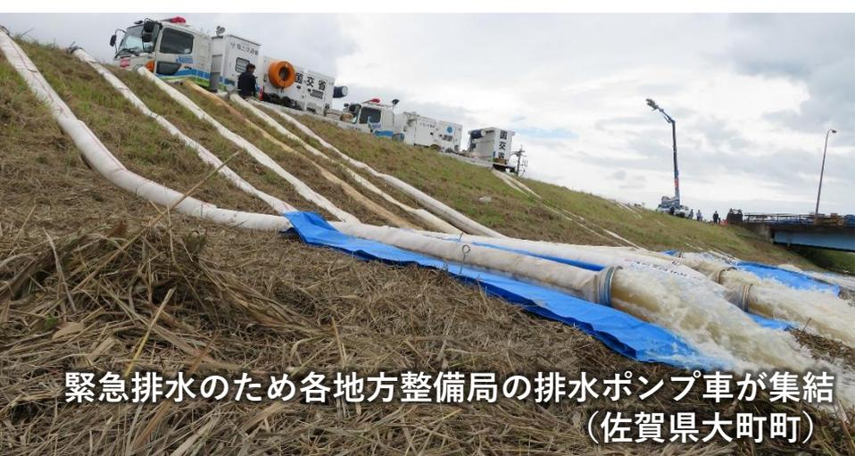
緊急排水のため各地方整備局の排水ポンプ車が集結
