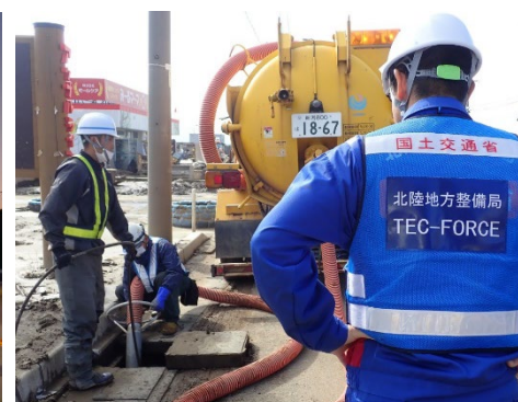
協力企業と一体となった堆積土砂の撤去 (長野県長野市)
