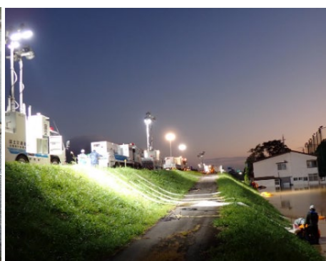
排水ポンプ車による24時間体制の緊急排水 (長野県飯山市)
