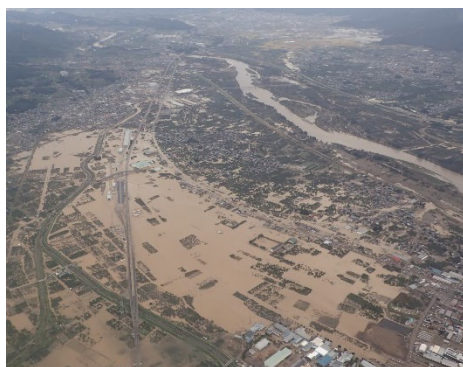
防災ヘリによる千曲川上空の浸水調査 (長野県長野市)
