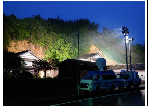
土砂崩れ箇所の監視支援(珠洲市)
