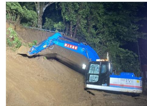
遠隔操縦式バックホウによる道路啓開支援
