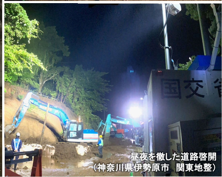
建設業団体等と連携した道路啓開 (神奈川県伊勢原市 関東地整)
