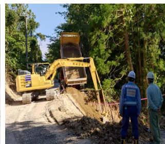
道路啓開作業 (石川県珠洲市)
