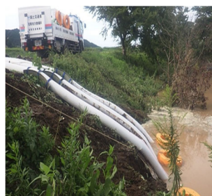
排水作業(町野川) (石川県輪島市)
