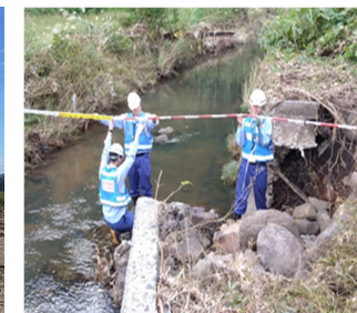
被災状況調査(河川) (石川県輪島市)
