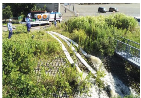
排水ポンプ車による排水支援[内水排除] (石川県金沢市)
