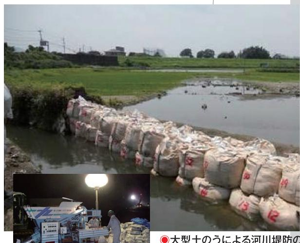
●大型土のうによる河川堤防の応急復旧
