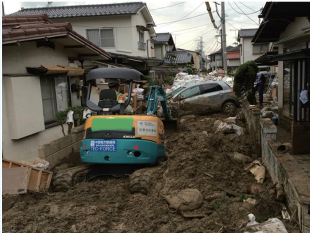
○地域の建設業者による堆積土砂の撤去
