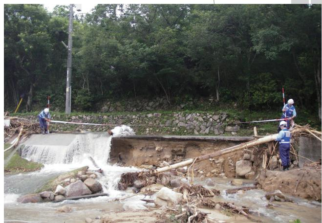
●土石流による道路の被災状況調査
