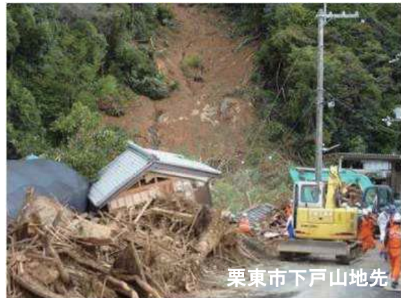
斜面崩壊状況
