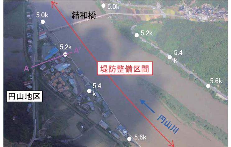
平成25年台風18号洪水の浸水状況
