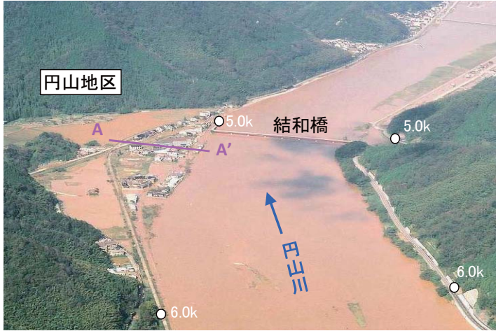
平成16年台風23号洪水の浸水状況
