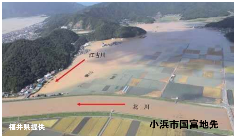
北川水系江古川 越水状況
