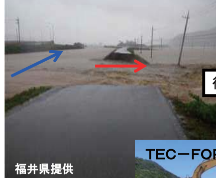
堤防決壊状況
