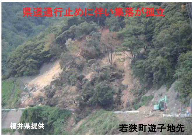
常神半島 法面崩壊発生状況
