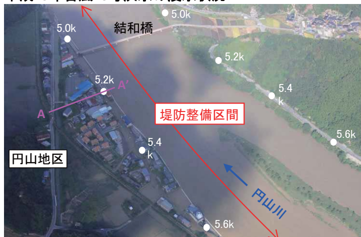
平成25年台風18号洪水の浸水状況
