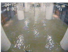
平成16年10月 台風22号 東京外口麻布十番駅
