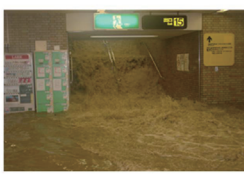
平成15年7月 梅雨前線による豪雨 福岡市営地下鉄博多駅
