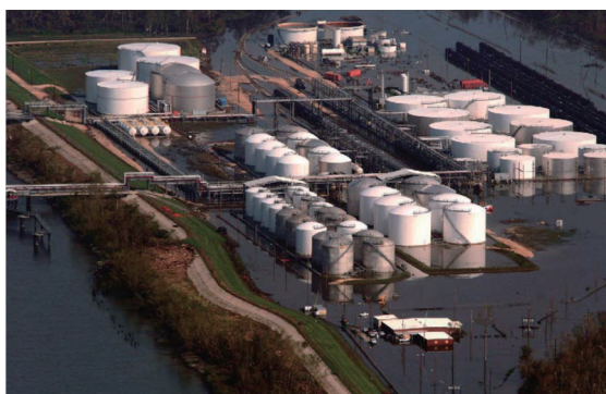
【図 2-18-4 浸水したガソリン貯蓄タンク（ニューオリンズ、ルイジアナ州）】
