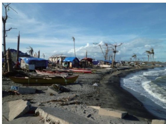
【図 2-21-7 タナワン周辺の漁村の被災状況】
