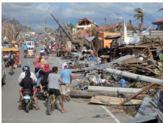
【図 2-21-8 タクロバンの被災状況】
