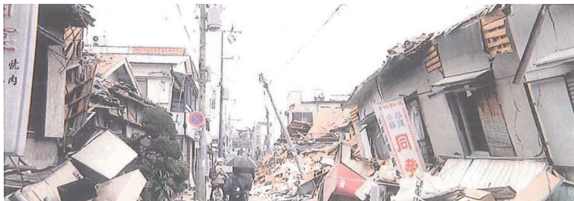
【図 2-13-5 建物の倒壊】
