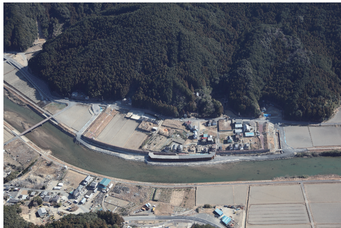
【図 2-6-13 緊急復旧後（平成 24 年 2 月 4 日）】
