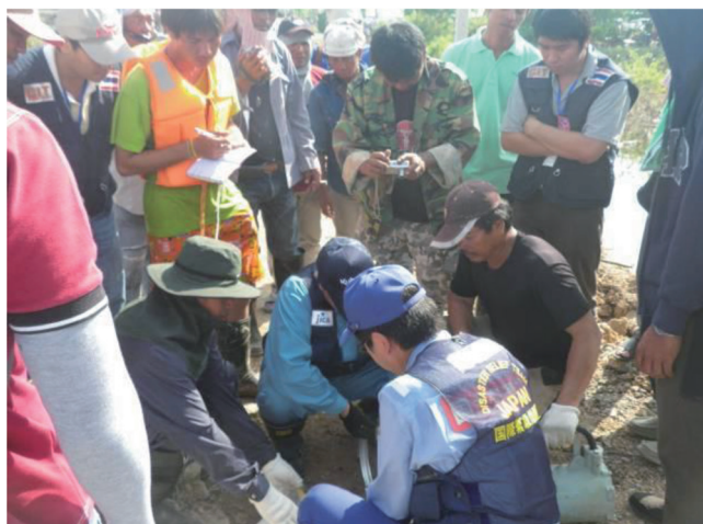
【図 2-19-8 TEC-FORCE による現地作業員への技術指導】
