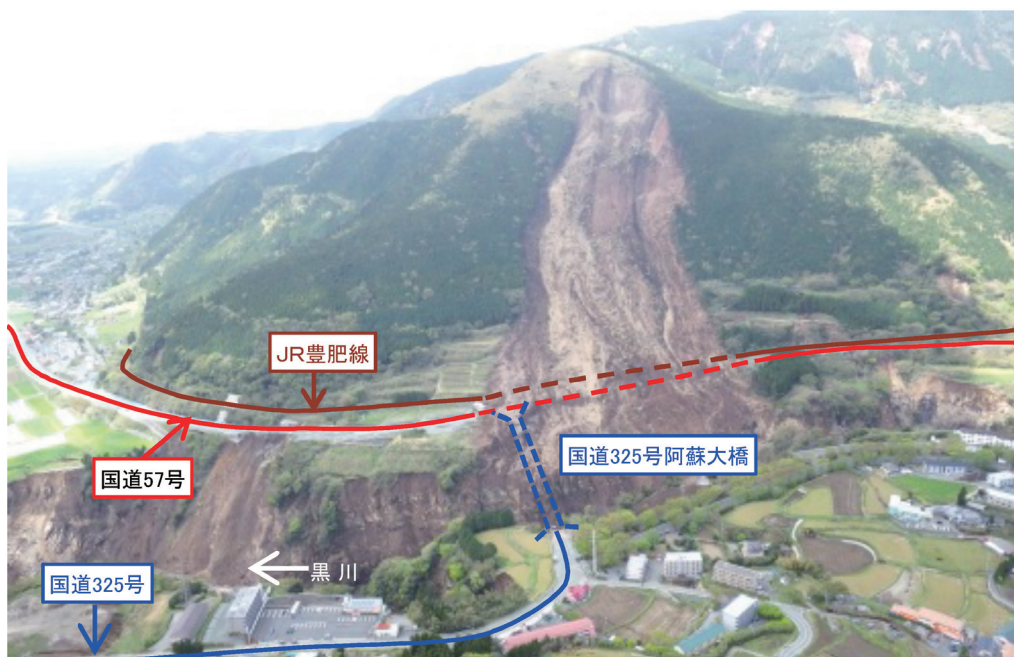
【図 2-15-3 南阿蘇村阿蘇大橋地区(斜面崩壊による道路、鉄道の寸断)】
