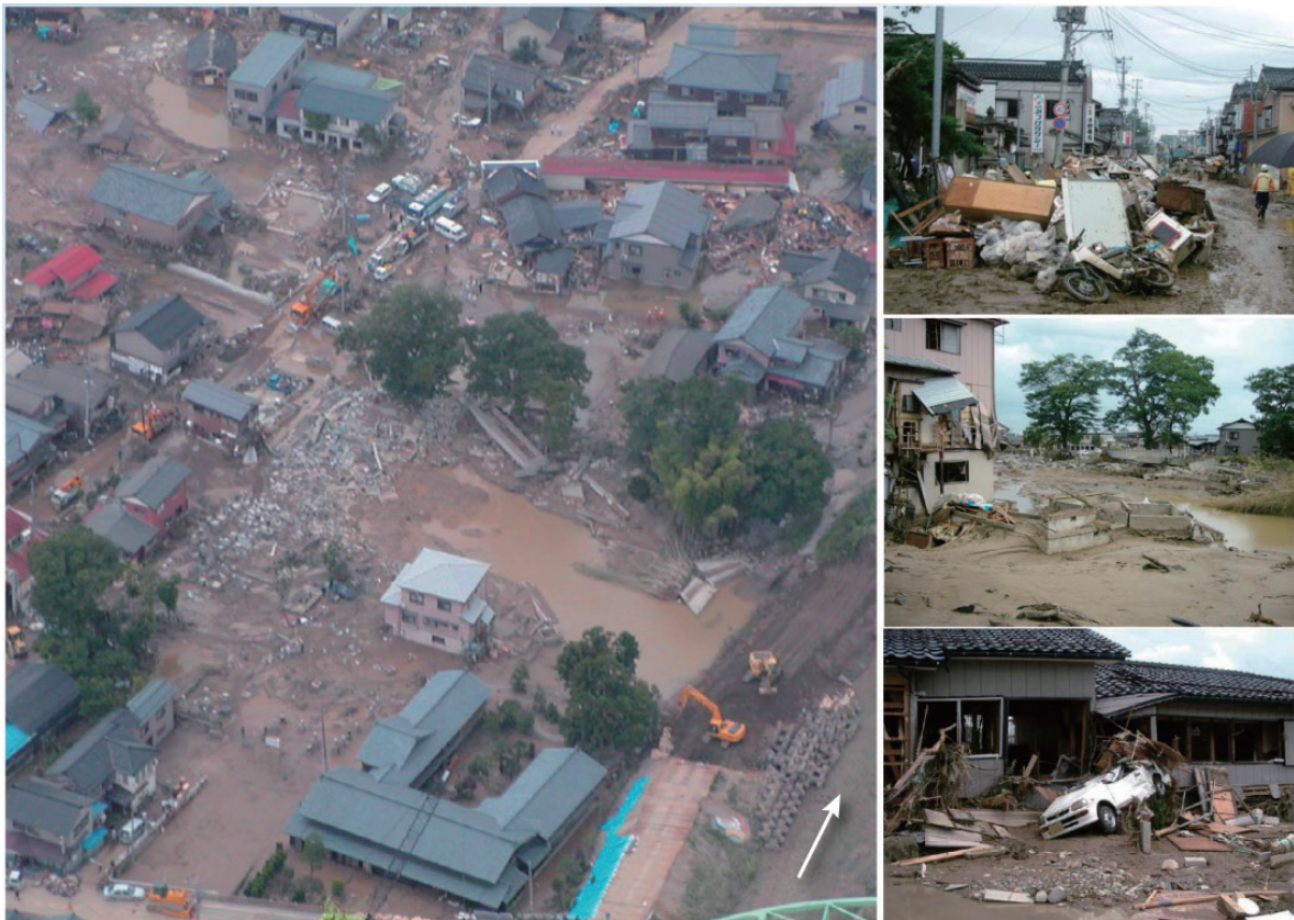
【図 2-4-4 刈谷田川破堤後の状況（新潟県中之島町：現・長岡市）】
