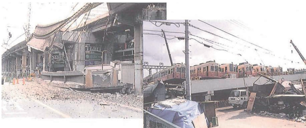
【図 2-13-7 鉄道の被害】
