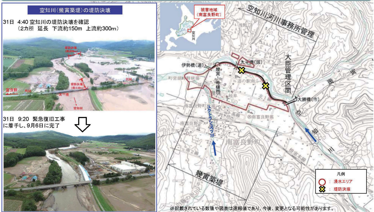
【図 2-12-13 台風第 10 号による石狩川水系空知川の被災状況】
