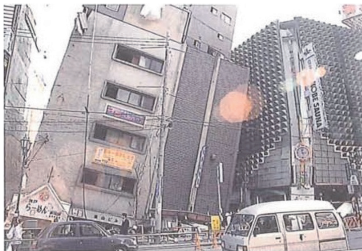
【図 2-13-4 建物の倒壊】
