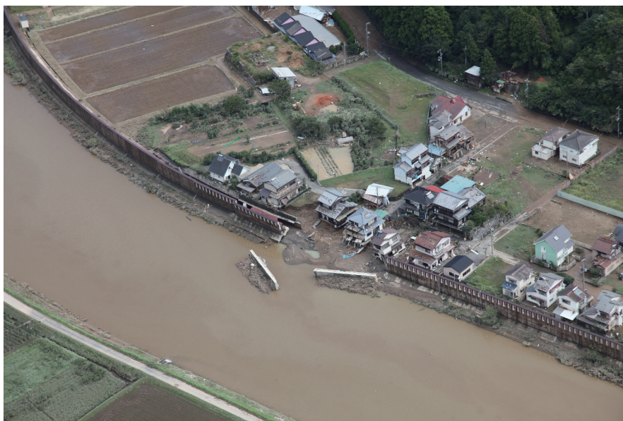
【図 2-6-12 高岡地区輪中堤（9月5日）】
