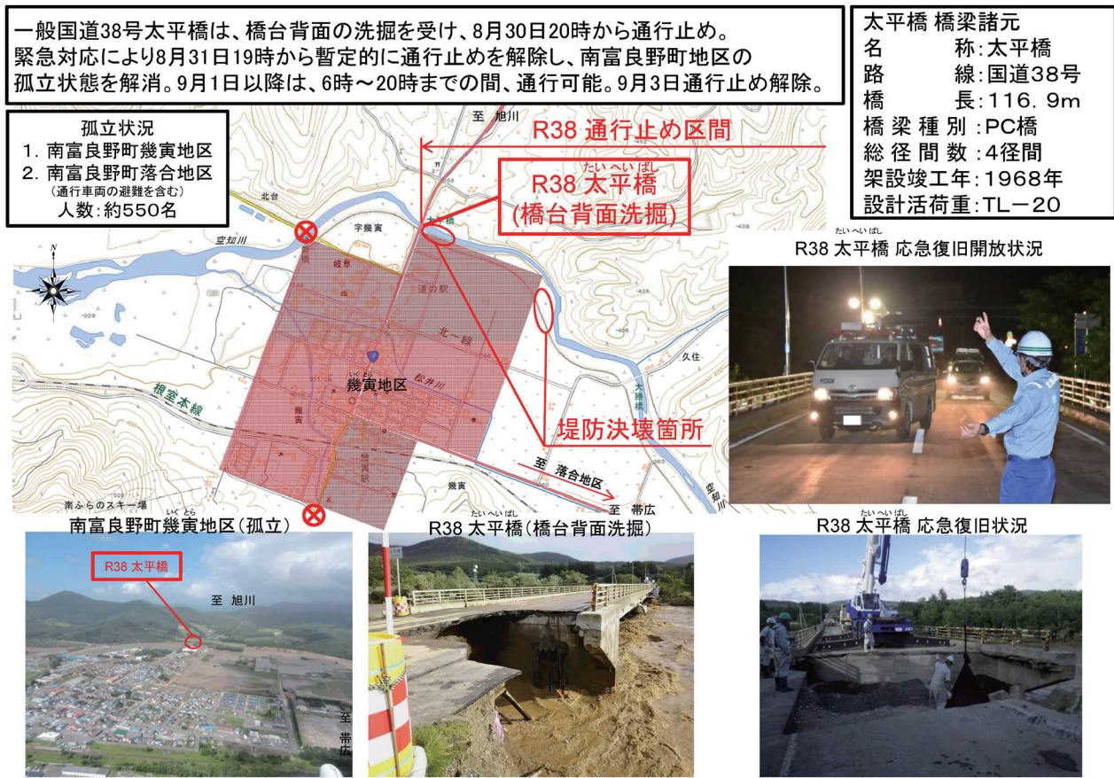
【図 2-12-14 国道 38 号太平橋の応急復旧 (南富良野町幾寅・落合地区の孤立解消)】
