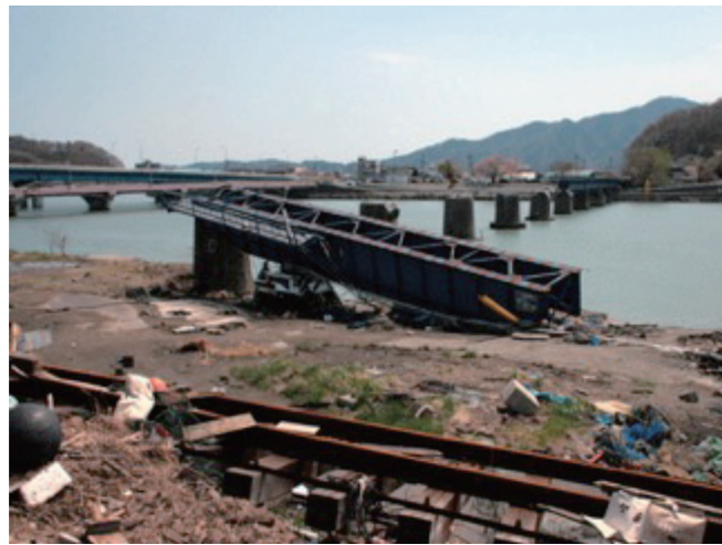
【図 2-14-10 J R山田線（宮古駅付近）】
