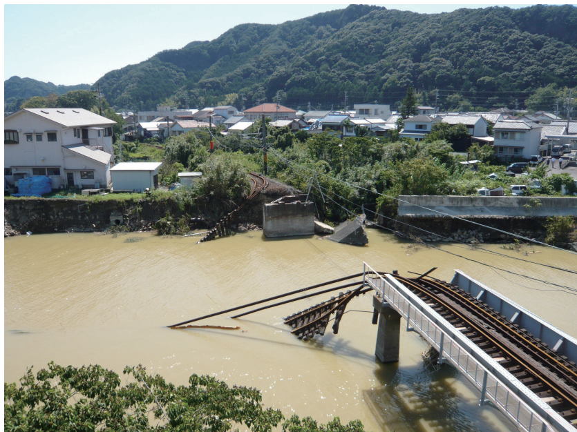
【図 2-6-10 紀勢本線那智川橋梁 (落橋)】
