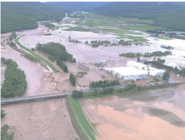
【図 2-12-6 堤防の決壊による氾濫状況(石狩川水系空知川)】
