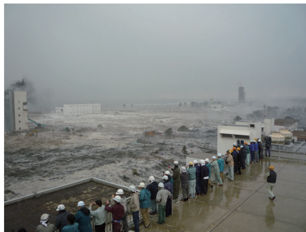
【図2-14-16 津波により被災する南蒲生浄化センター(宮城県仙台市)】
