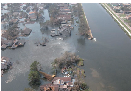
【図 2-18-3 堤防の決壊状況（写真：米国陸軍工兵隊）】
