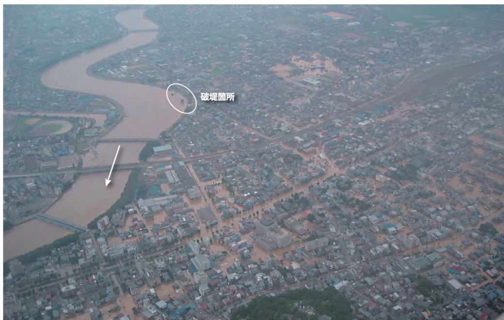
【図 2-5-3 足羽川左岸浸水状況（福井市）】
