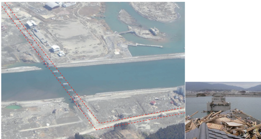
【図 2-14-8 宮城県気仙沼市（国道 45 号気仙大橋）】
