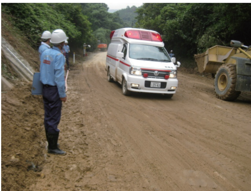
【図 2-8-7 道路啓開後の救急車両の運行（山口県）】
