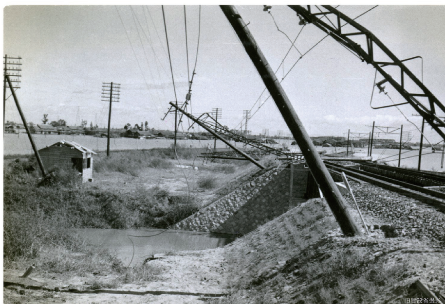
【図 2-2-4 鉄道の被災状況】
