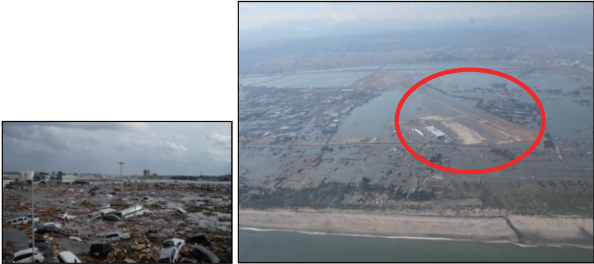
【図 2-14-12 宮城県仙台市（仙台空港）】
