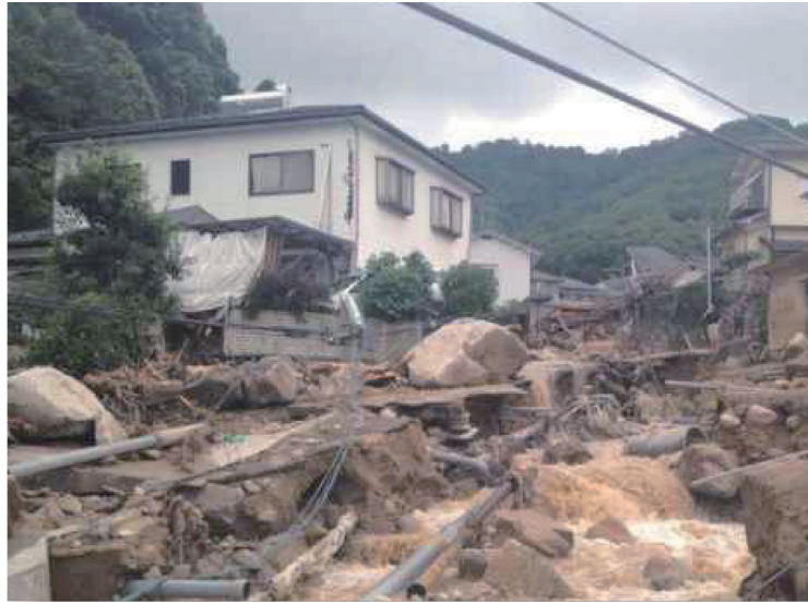
【図 2-10-2 土石流による被災状況（広島市安佐南区緑井）】
