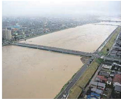
【図 2-3-5 国道1号一色大橋付近の状況】
