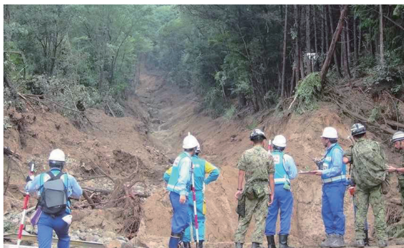
【図 2-10-7 土砂災害発生現場の点検 (広島市土砂災害 8月24日)】
