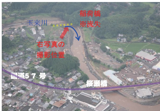
【図 2-7-7 大野川水系玉来川被災状況】
