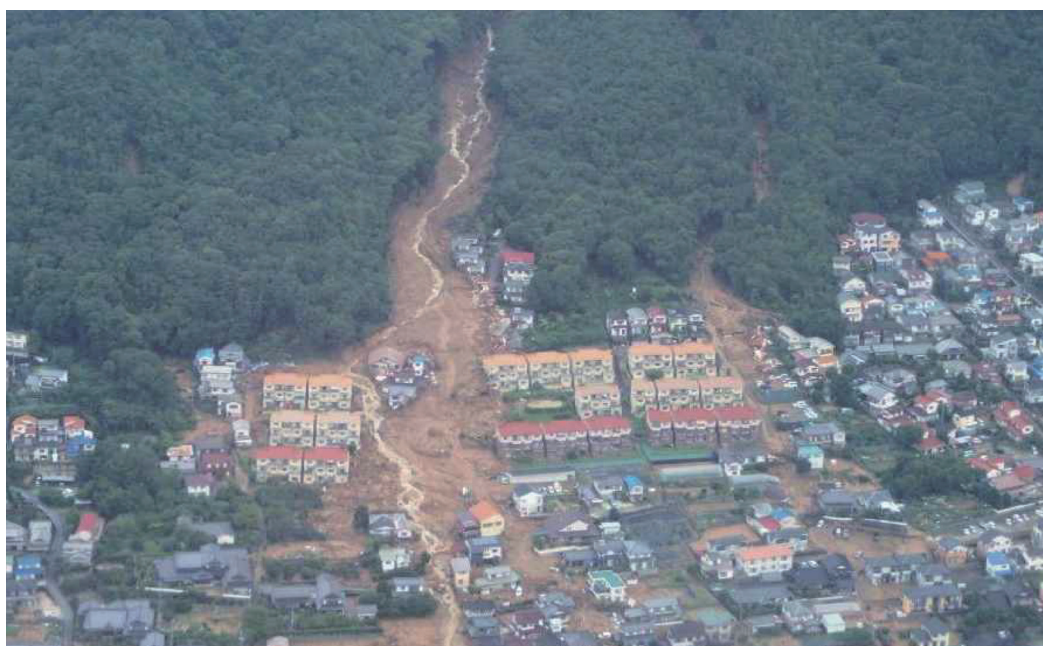
【図 2-10-1 土石流による被災状況（広島市安佐南区）】
