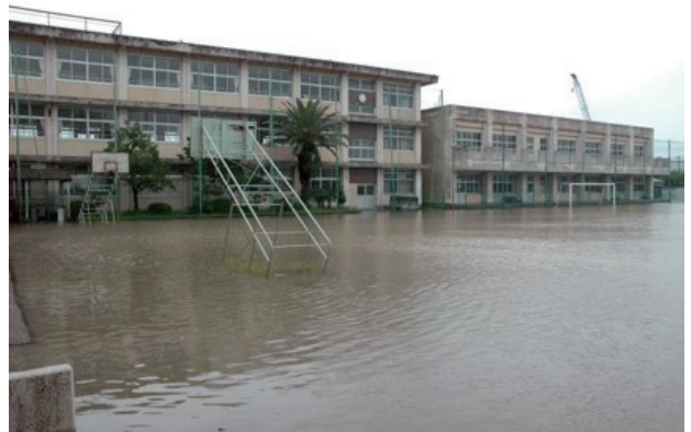
【図 2-7-6 浸水状況柳川市大和町大和中学校】
