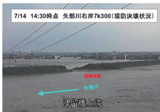
【図 2-7-10 矢部川右岸 7k300（堤防決壊状況）7 月 14 日 14:30 時点】
