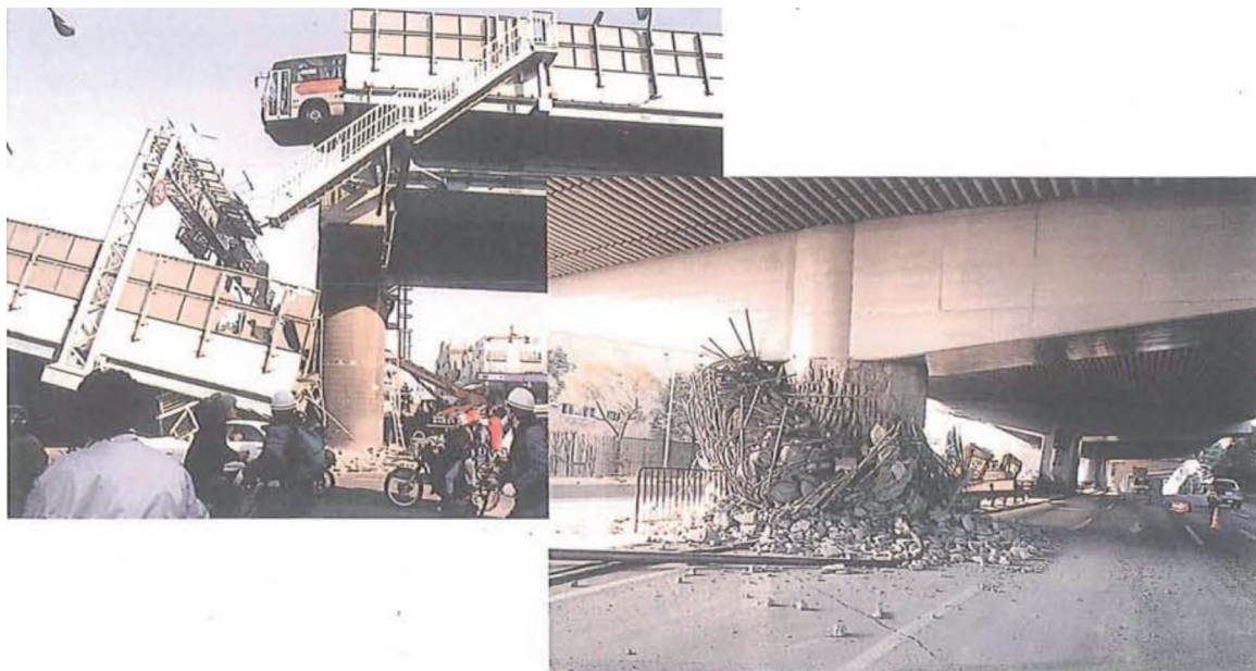
【図 2-13-6 高速道路の倒壊】
