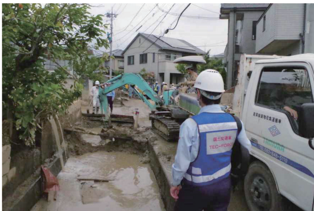
【図 2-10-9 被災地の排水のため八木用水の土砂撤去の支援 （広島市土砂災害 9月1日）】
