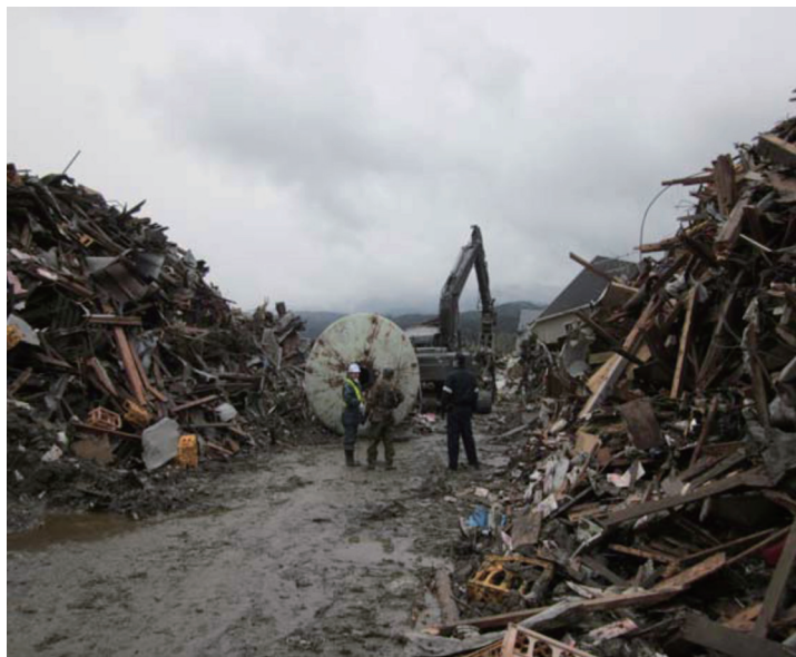
【図 2-14-25 啓開作業中 (岩手県陸前高田市内)】
