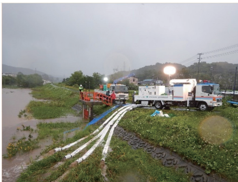
【図 2-12-15 ポンプ車による氾濫水の排水（北海道浦河町）】
