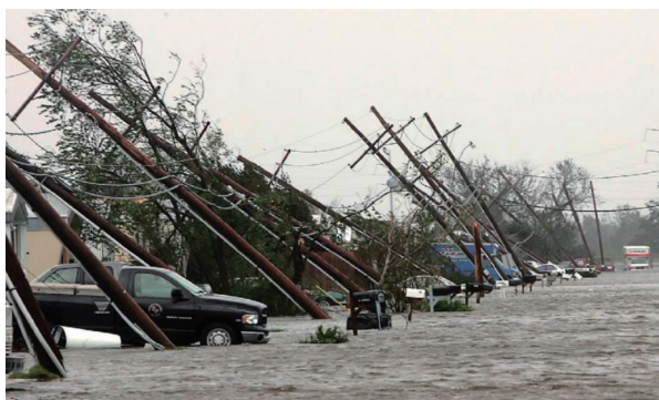
【図 2-18-5 倒れた電柱（Gretna、ルイジアナ州）】
