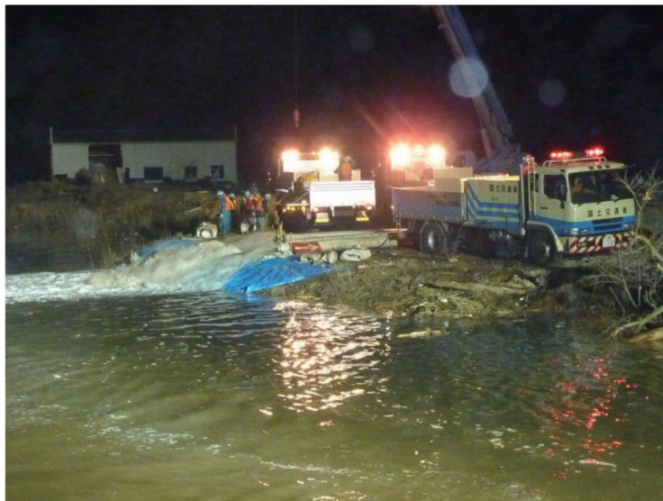
【図 2-14-30 排水作業状況 (石巻市釜谷地区)】
