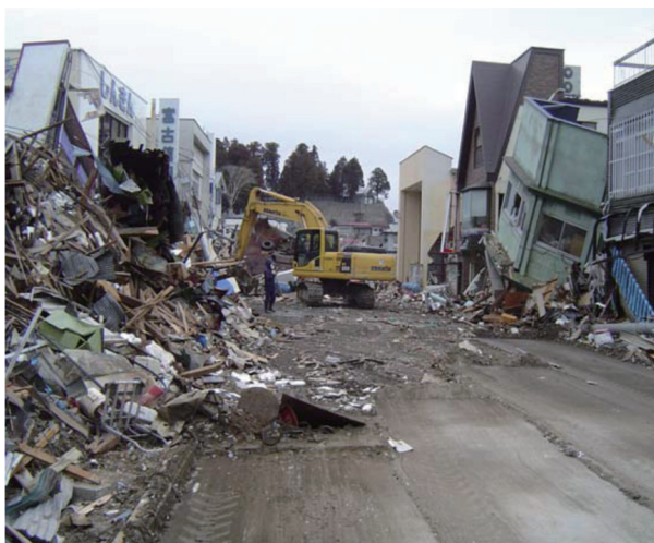
【図 2-14-26 啓開作業中（岩手県山田町内）】
