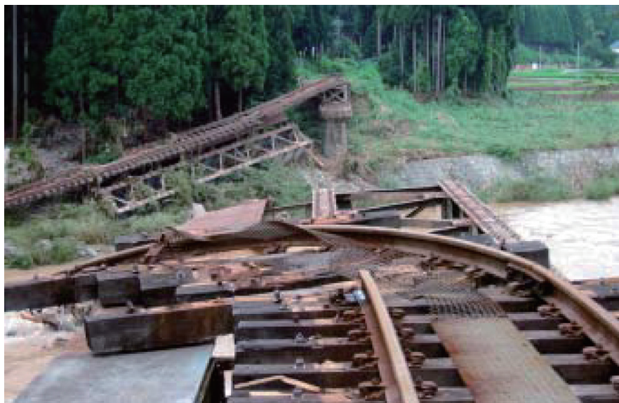
【図 2-5-6 流失したJR越美北線の足羽第3鉄橋（美山町：現・福井市） 【写真提供／福井県土木部】】
