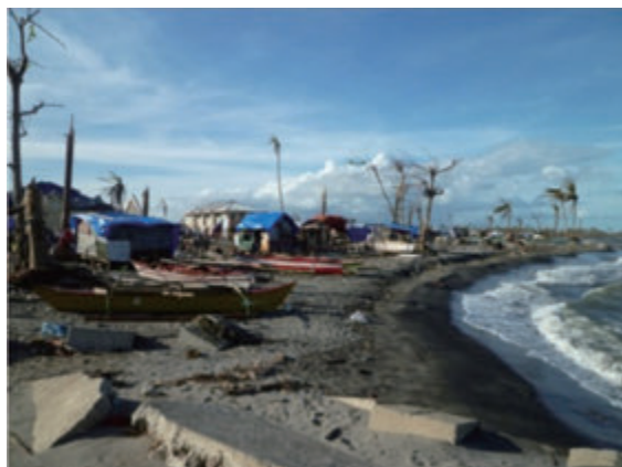
【図 2-21-7 タナワン周辺の漁村の被災状況】
