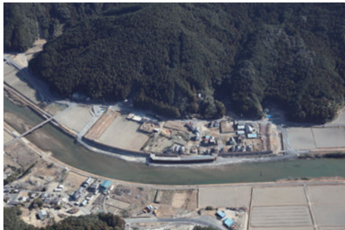
【図 2-6-13 緊急復旧後（平成 24 年 2 月 4 日）】
