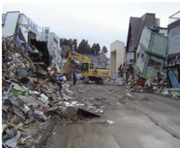
【図 2-14-26 啓開作業中（岩手県山田町内）】
