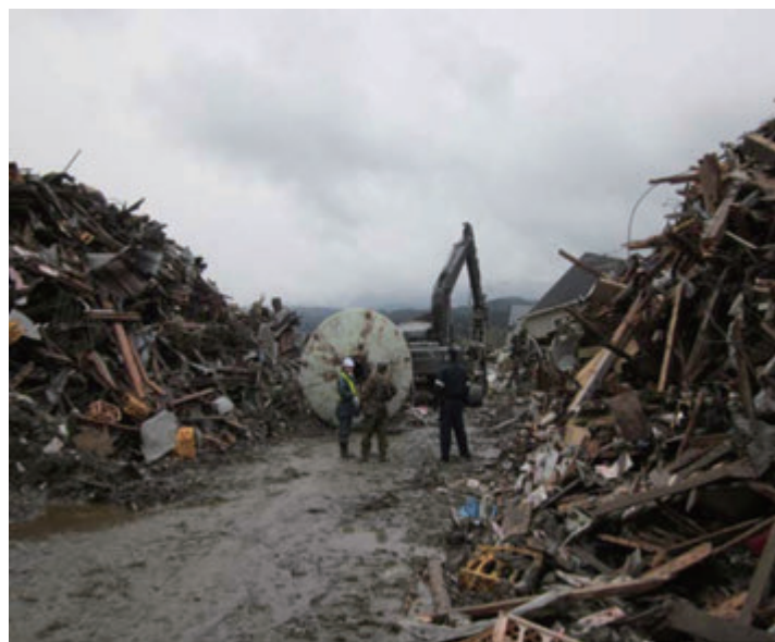
【図 2-14-25 啓開作業中（岩手県陸前高田市内）】
