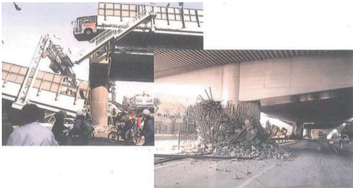
【図 2-13-6 高速道路の倒壊】
