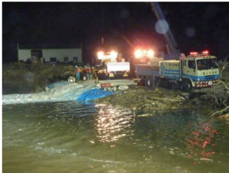
【図 2-14-30 排水作業状況（石巻市釜谷地区）】
