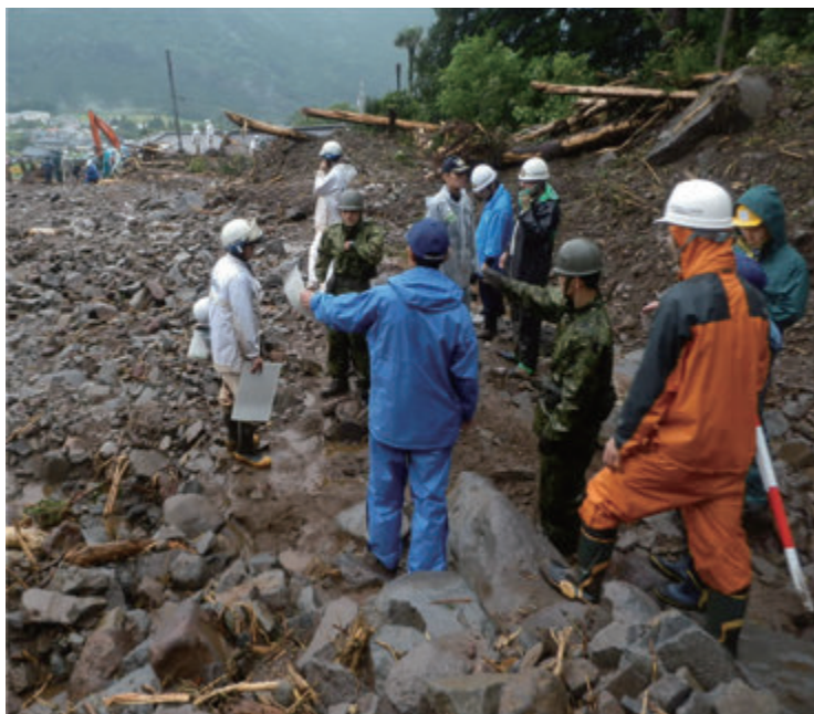
【図 2-7-13 行方不明者の搜索のための自衛隊・警察等への土砂災害 専門家による技術指導状況（熊本県阿蘇市）】
