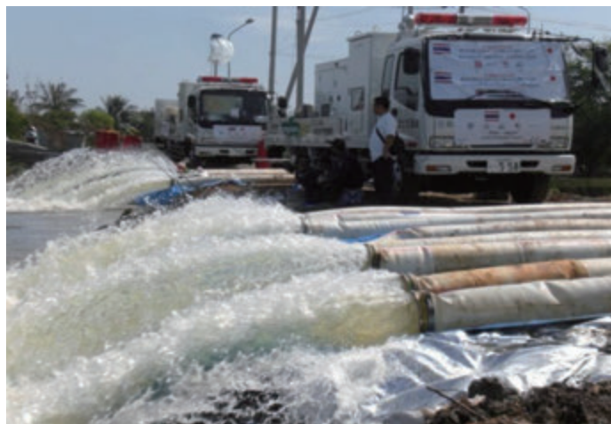
【図 2-19-4 ポンプ排水の状況】
