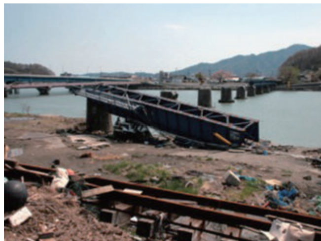
【図 2-14-10 J R山田線（宮古駅付近）】
