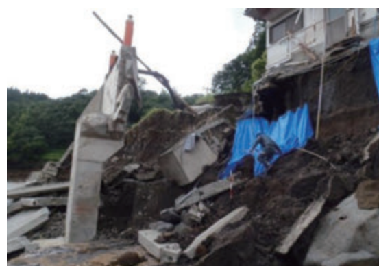
【図 2-7-8 大野川水系玉来川稲荷橋流出状況】
