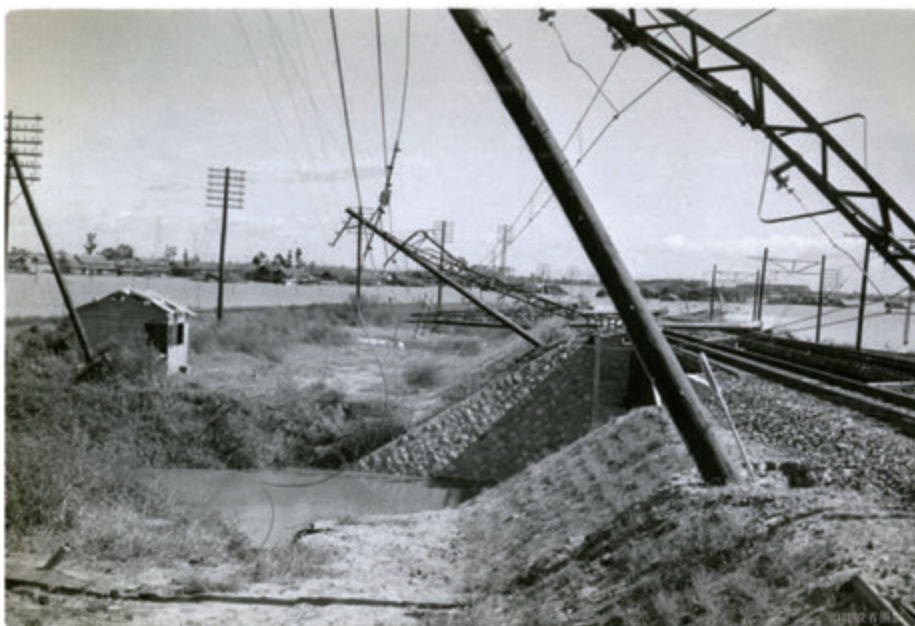
【図 2-2-4 鉄道の被災状況】
