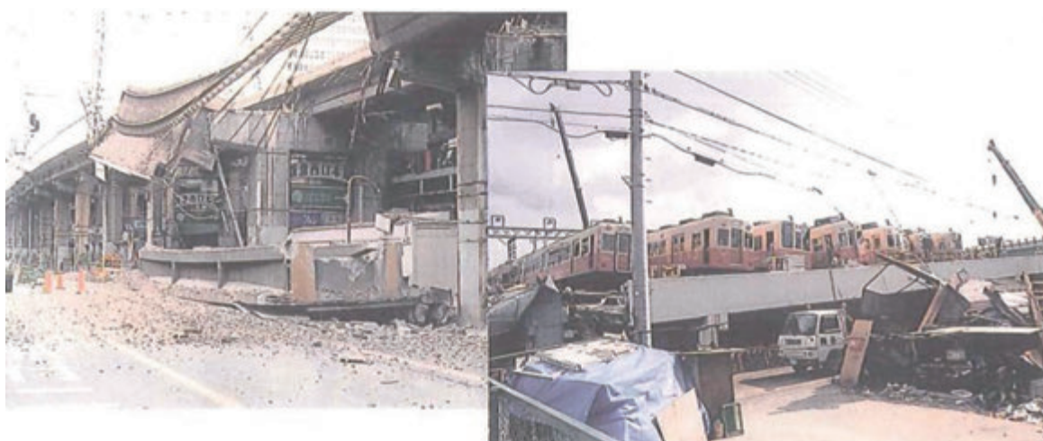
【図 2-13-7 鉄道の被害】
