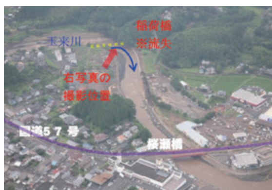
【図 2-7-7 大野川水系玉来川被災状況】
