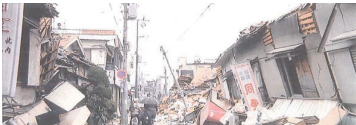
【図 2-13-5 建物の倒壊】
