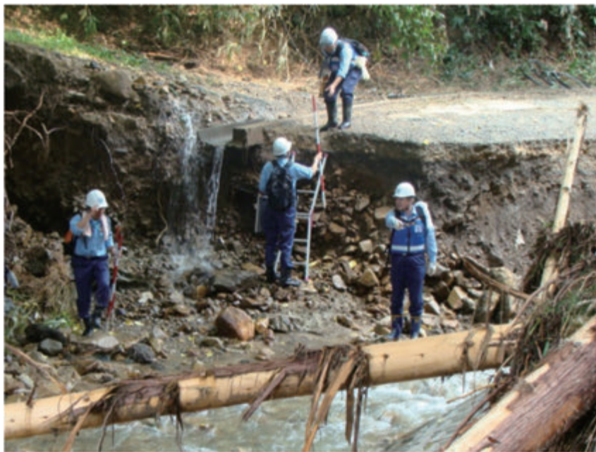
【図 2-8-6 町道木尾谷線における被災状況調査（島根県）】
