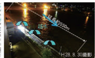
① 久慈川（右岸）越水状況
