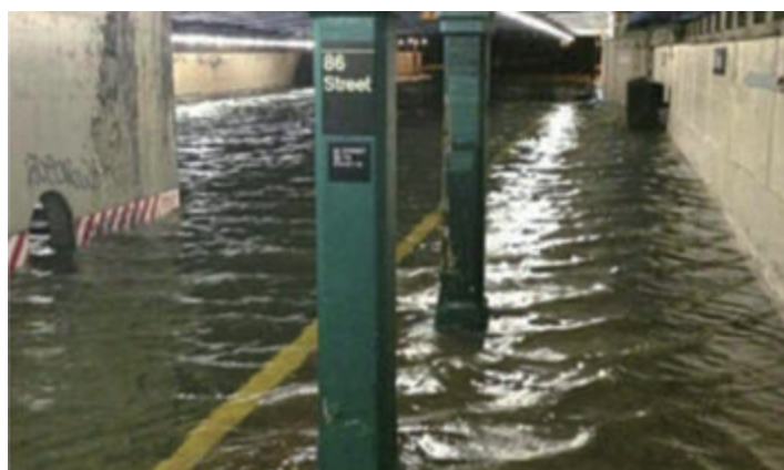
【図 2-20-2 地下鉄 86 ストリート駅の冠水状況（©MTA）】
