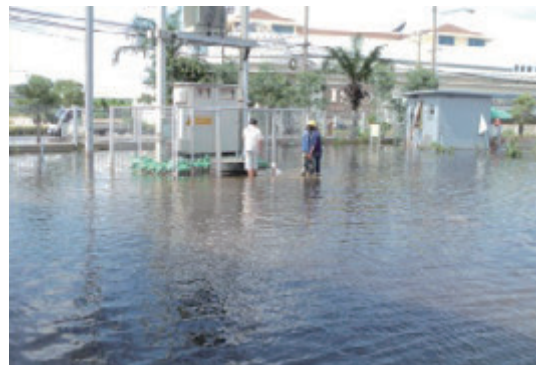
【屋外の電気パネルを土のうで囲んで対応】
