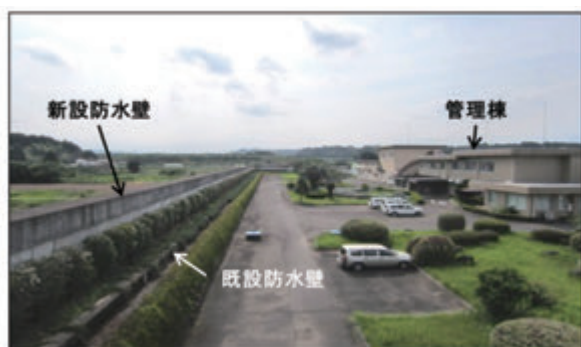
【富吉浄水場の全周防水壁】
