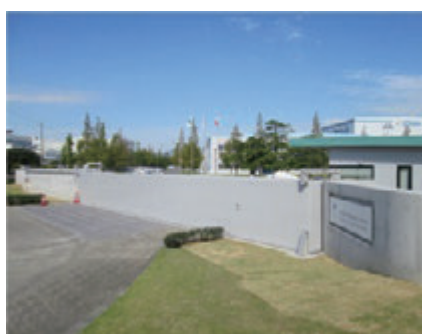
【外周防潮堤の一部】
