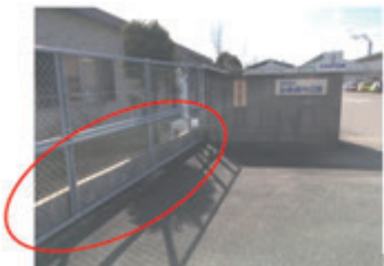
【対策の状況（正門横に止水壁を設置、正門は土のうで防御）】
