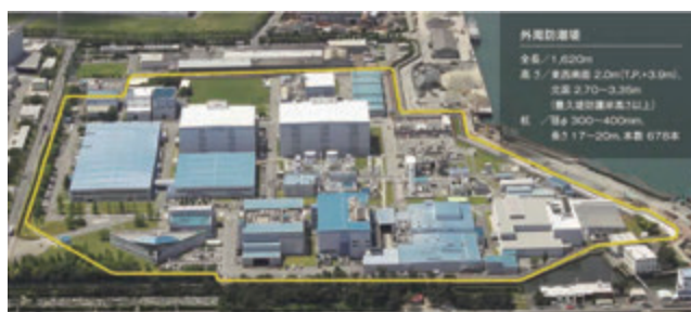
【外周防潮堤の概要（松茂工場）】
