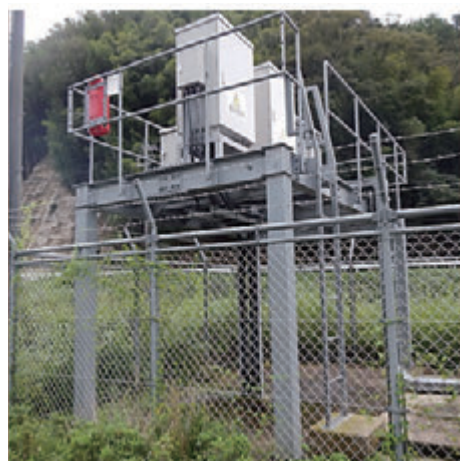
【対策後の状況】
