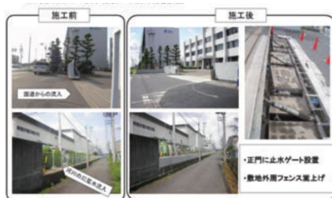
【止水ゲート設置・敷地かさ上げ】
