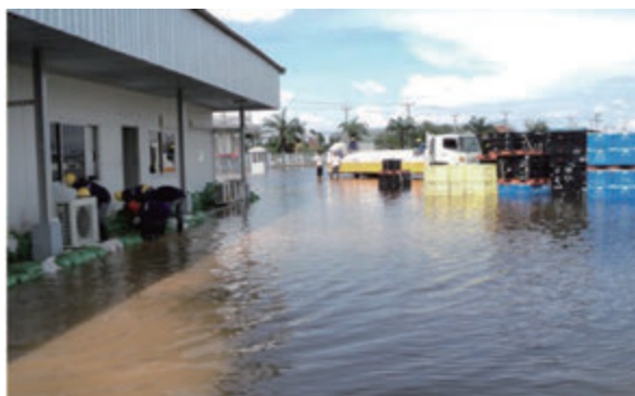
【トラックヤードの浸水高が 30cm を超え、事務所内も 20cm ほど浸水】
