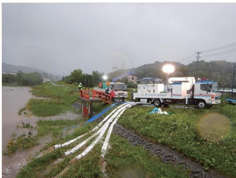
【図 2-12-15 ポンプ車による氾濫水の排水（北海道浦河町）】
