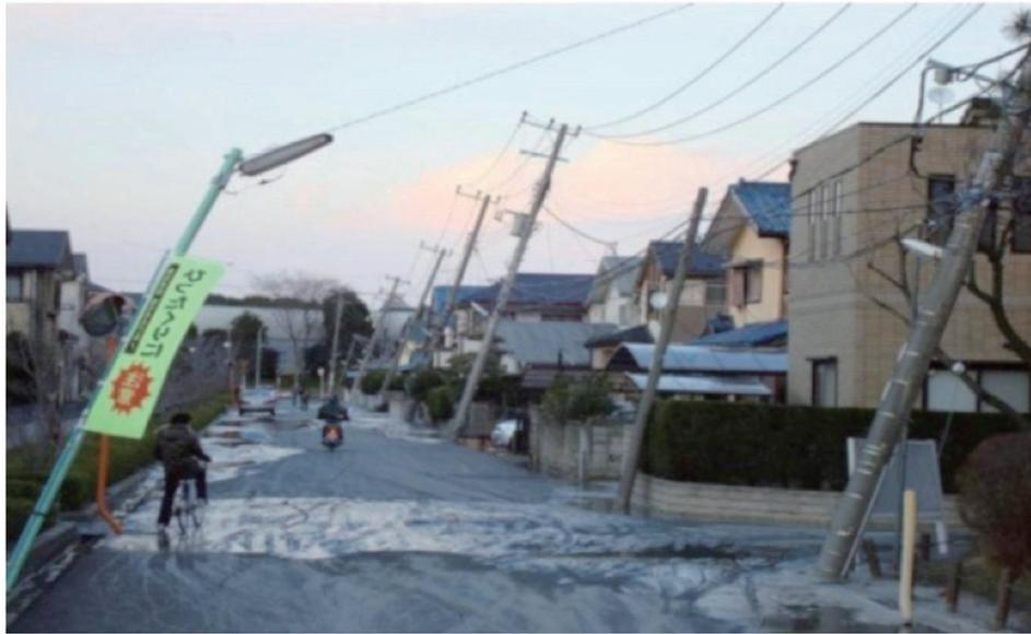
【図 2-14-7 傾いた電柱（千葉県習志野市）】
