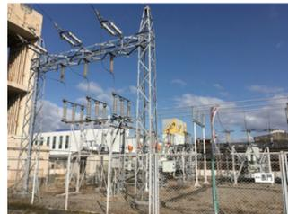
【対策の状況（受電設備、主要な設備は工場内で比較的地盤の高い位置に設置）】
