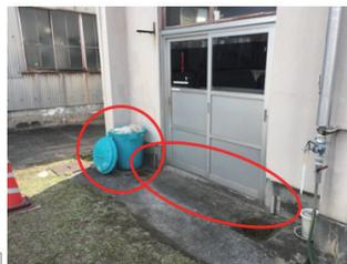
【対策の状況（建屋の出入り口に止水板を設置できるようにしている。また、土のうはポリバケツに入れて出入り口横に配置）】
