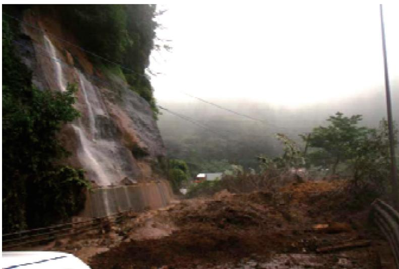
【図 2-7-9 熊本県阿蘇市滝室坂国道 57 号法面崩落状況
