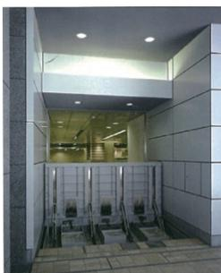
【ビルの出入口の止水板】
