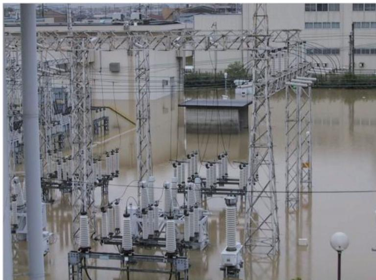
【図 2-3-6 浸水による変電所の冠水（中部電力提供）】
