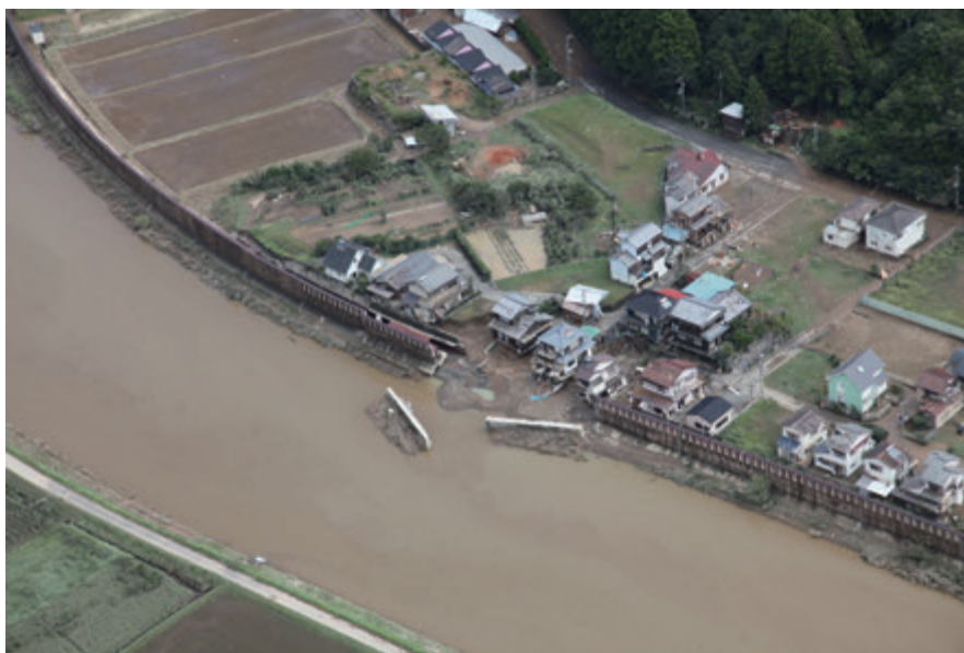
【図 2-6-12 高岡地区輪中堤（9 月 5 日）】
