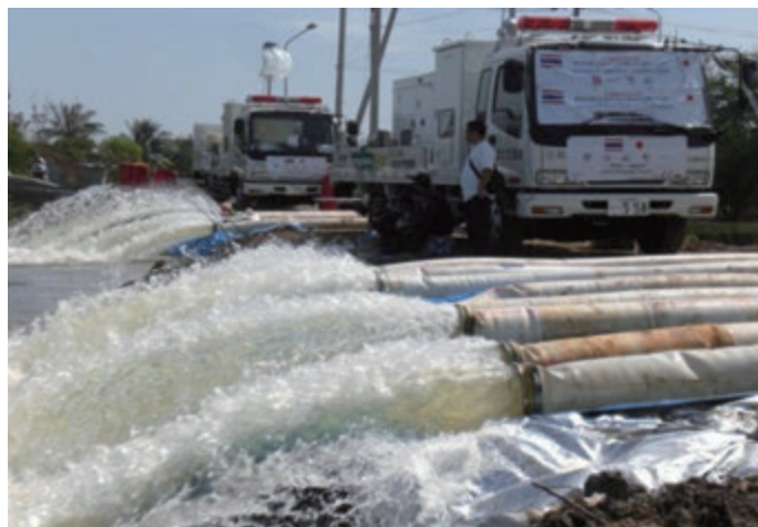
【図 2-19-4 ポンプ排水の状況】
