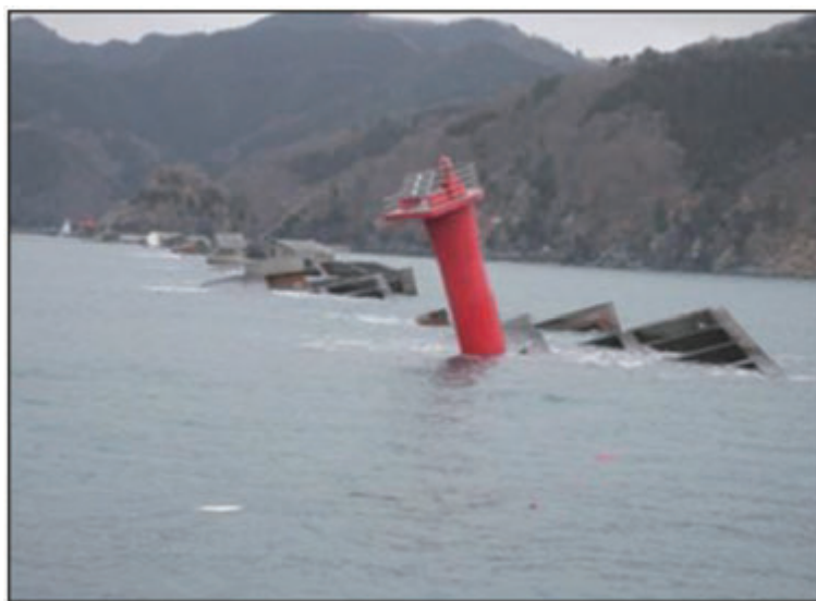
【図 2-14-13 岩手県釜石市（釜石港）】
