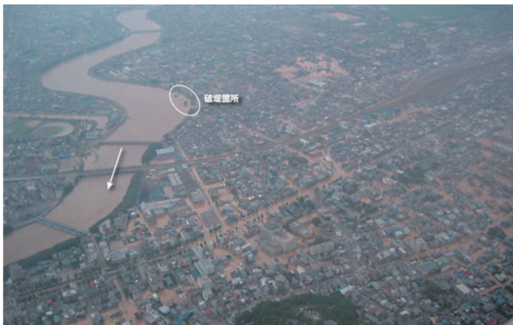
【図 2-5-3 足羽川左岸浸水状況（福井市）】
