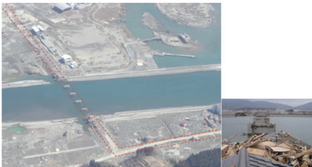
【図 2-14-8 宮城県気仙沼市（国道 45 号気仙大橋）】
