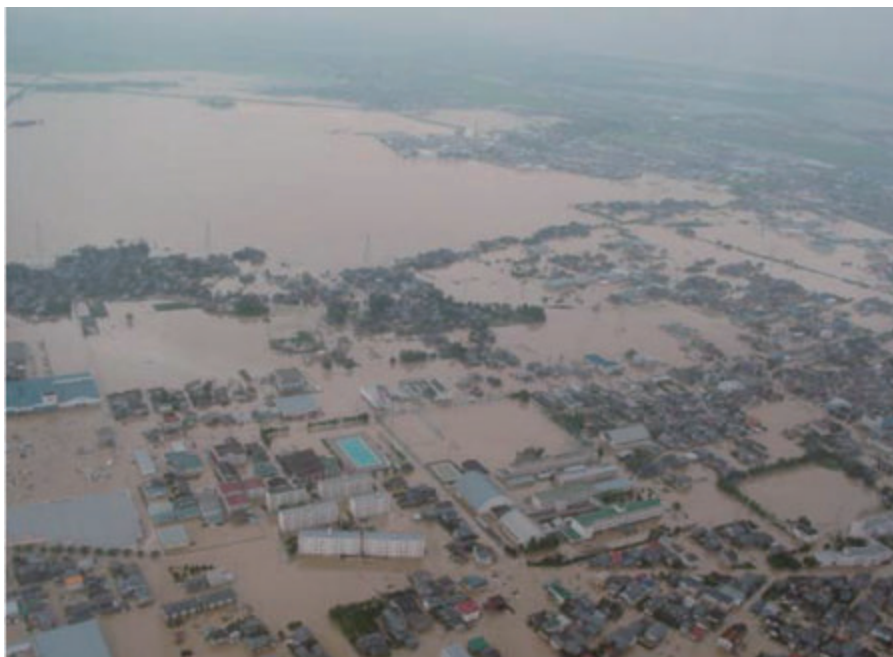
【図 2-4-3 浸水した新潟県三条市街（写真提供／北陸地方整備局）】
