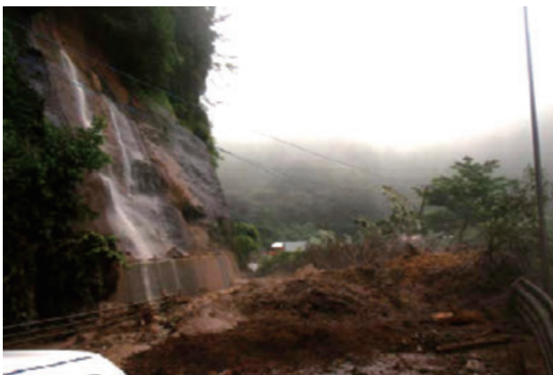
【図 2-7-9 熊本県阿蘇市滝室坂国道 57 号法面崩落状況 [写真提供／九州地方整備局]】
