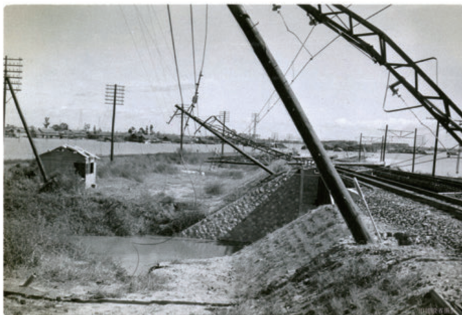
【図 2-2-4 鉄道の被災状況】
