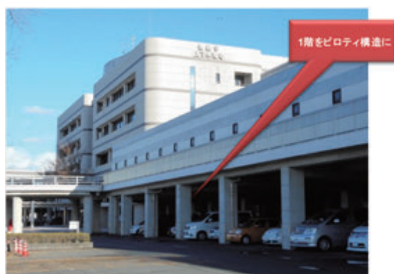
【上下水道局庁舎のかさ上げ例】
