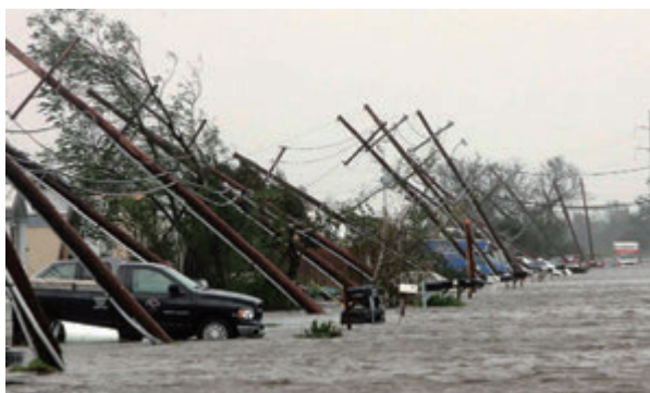
【図 2-18-5 倒れた電柱（Gretna、ルイジアナ州）】
