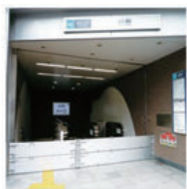
【①出入口の止水板】
