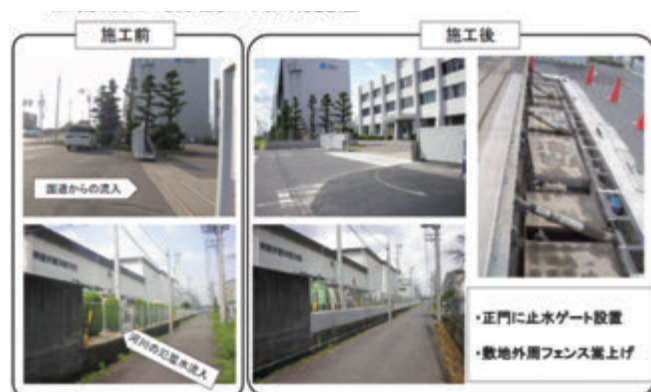
【止水ゲート設置・敷地かさ上げ】
