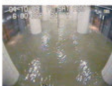
平成16年10月 台風22号 東京メトロ有楽町線
