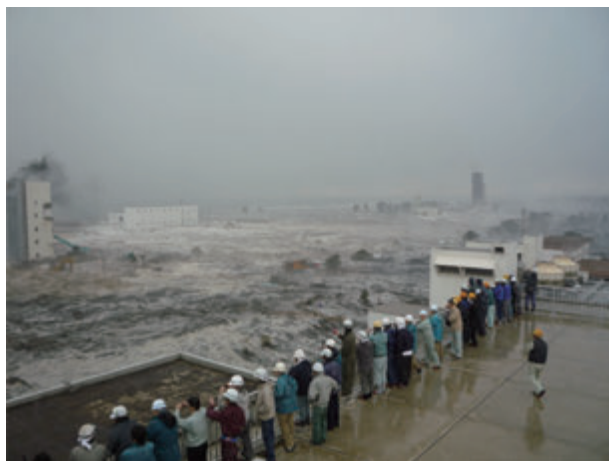
【図2-14-16 津波により被災する南蒲生浄化センター（宮城県仙台市）】
