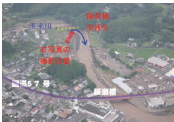
【図 2-7-7 大野川水系玉来川被災状況】
