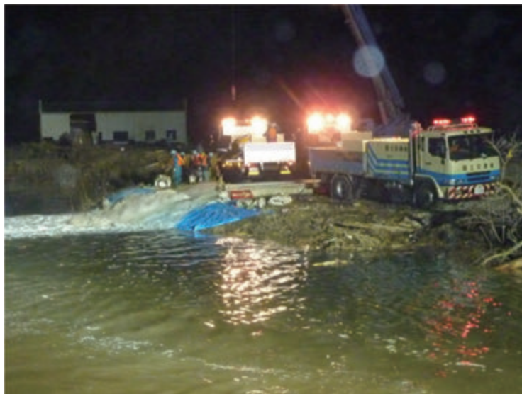
【図 2-14-30 排水作業状況（石巻市釜谷地区）】
