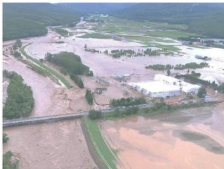
【図 2-12-6 堤防の決壊による氾濫状況（石狩川水系空知川）】
