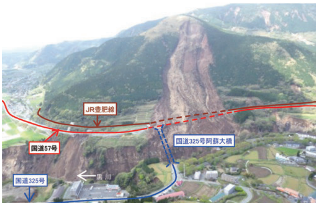
【図 2-15-3 南阿蘇村阿蘇大橋地区（斜面崩壊による道路、鉄道の寸断）】
