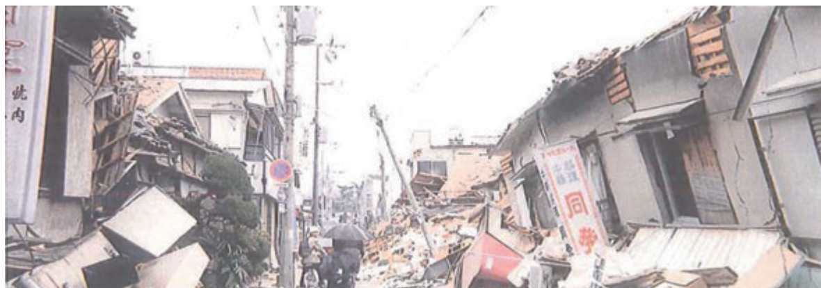
【図 2-13-5 建物の倒壊】
