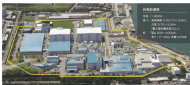
【外周防潮堤の概要（松茂工場）】
