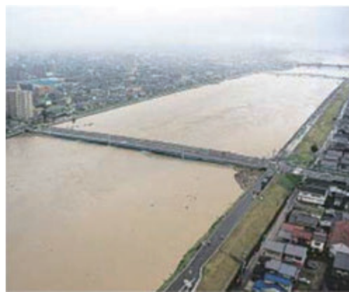
【図 2-3-5 国道 1 号一色大橋付近の状況】
