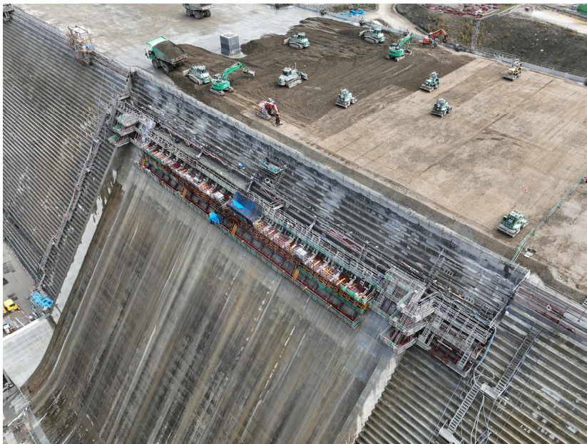
自動スライド型枠
