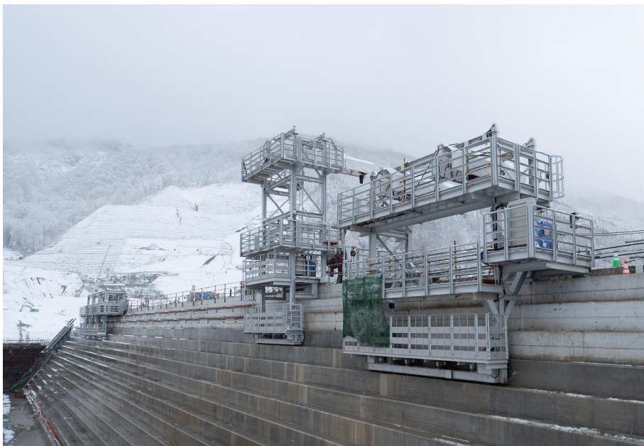
置き型枠自動スライドシステム
