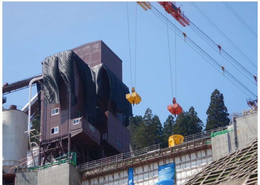
ケーブルクレーンの運転状況
