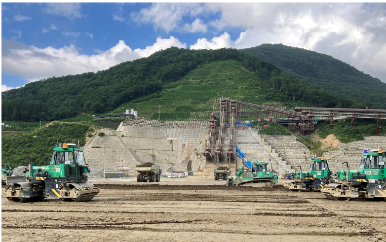
A 4 CSELによる施工状況
