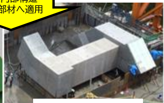
川上ダムフルPCa事例
