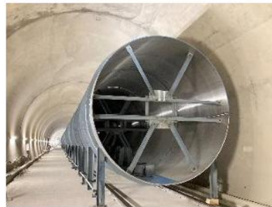
放流管据付・計測（トンネル内）
