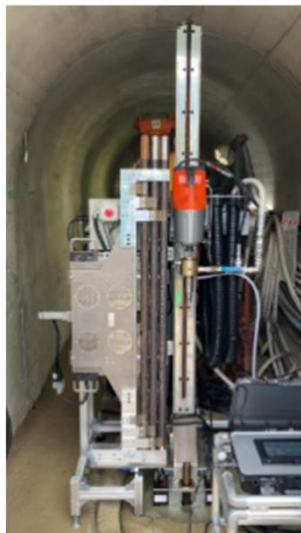
遠隔操作でのボーリング作業実施に向けた、試験施工の様子
