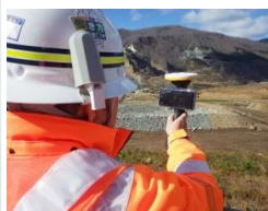
ハンディ型モニターを用いた現場でのCIMモデル確認
