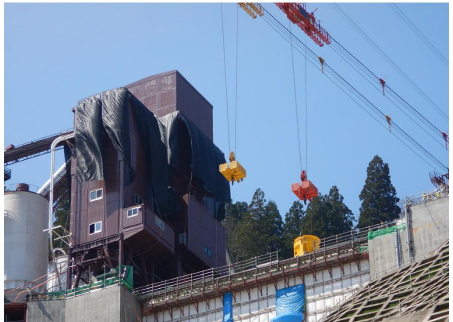
ケーブルクレーンの運転状況
