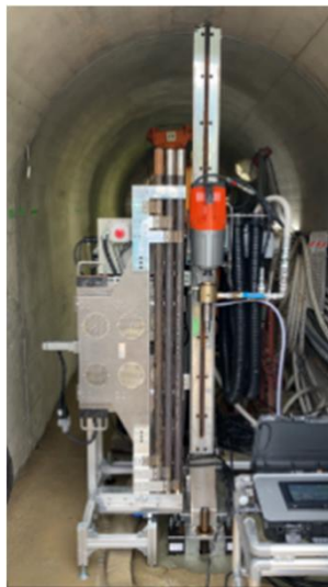
遠隔操作でのボーリング作業実施に向けた、試験施工の様子
