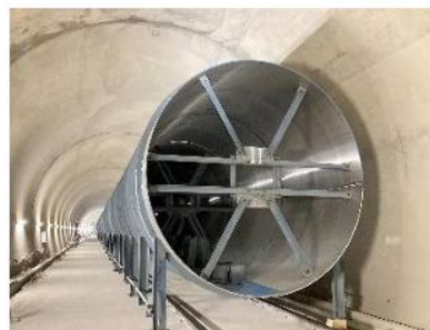
放流管据付・計測（トンネル内）
