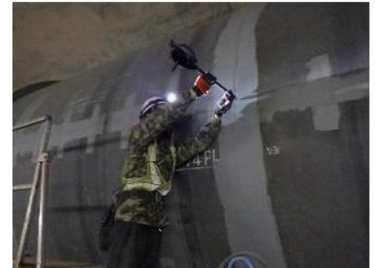
放流管据付・計測（トンネル内）
