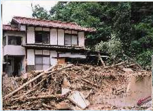
堂ヶ原川の被害状況
