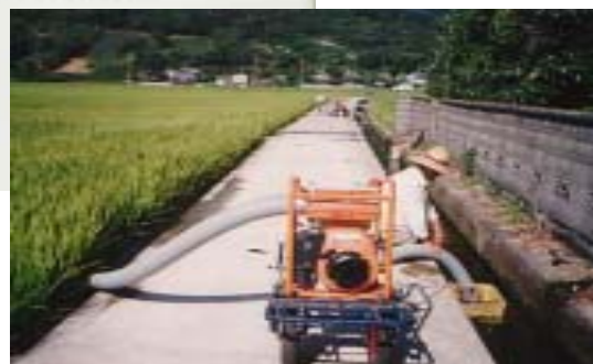
応急ポンプかんがい
