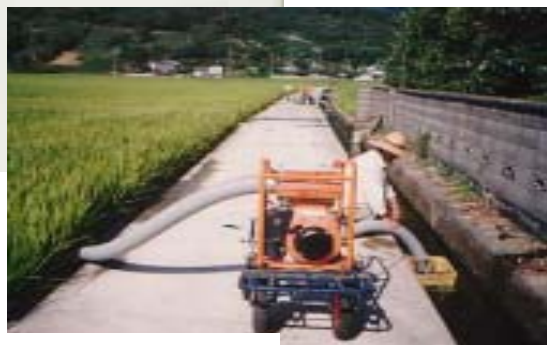
応急ポンプかんがい
