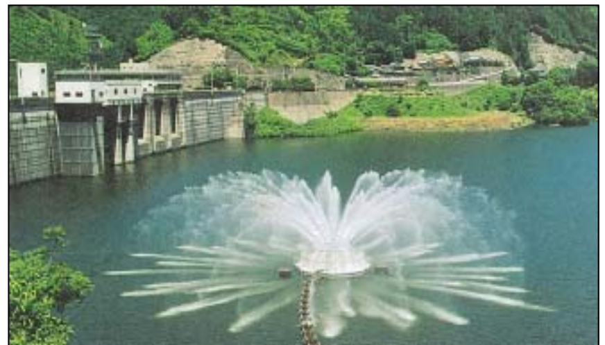
貯水池で噴水を兼ねた浅層曝気
