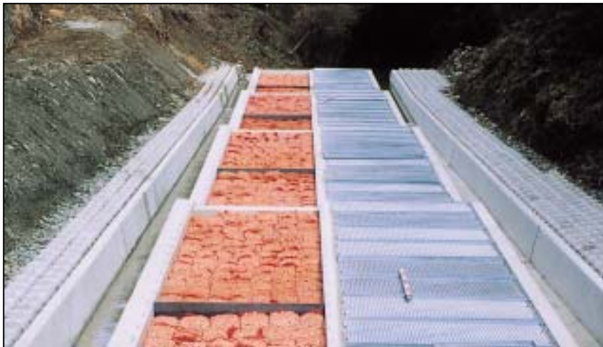
支川へのリン吸着材の敷設
