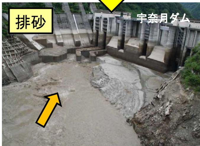
排砂ゲートを開け、貯水池にたまった土砂を排出する。
