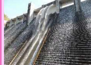
堤体の下流面を階段状にして豊かな表情を持たせているダム。ステップの高さは75cm。85段ある。
