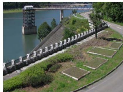
ダムサイト左岸
