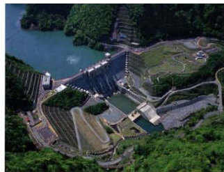
ダムサイト地区
