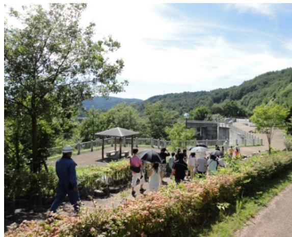
管理支所からダム堤体までの遊歩道
