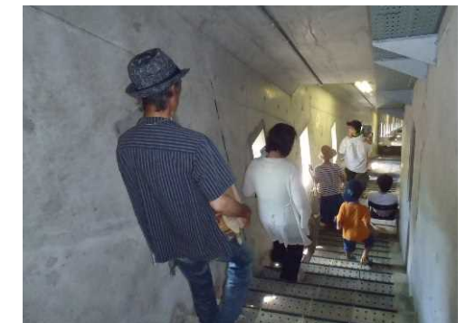
冬期連絡通路・階段639段
