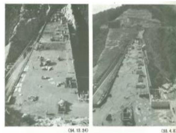
施工状況写真
