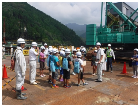
改造工事現場
