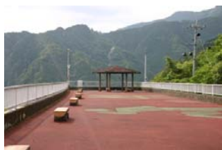
ダムサイト左岸
