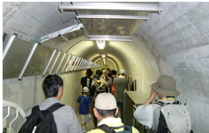
ダム内部 (クロスギャラリー)
