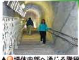
▲● 堤体内部へ通じる階段
