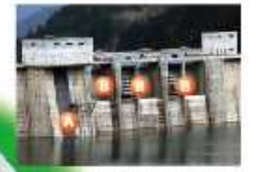
▲貯水池側から見た 選択取水塔(●)と 非常用洪水吐き(○)
