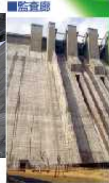
▲● 堤体下右岸にある 監視廊の入り口
