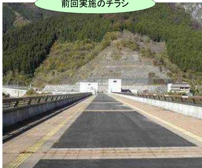
滝沢ダム天端 (道路)
