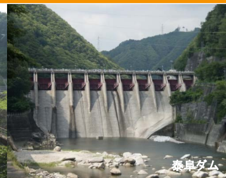
南向水力発電所
