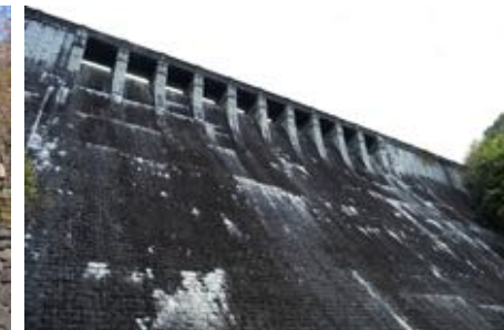
小ヶ倉ダム 石張りがとても美しいダム。
