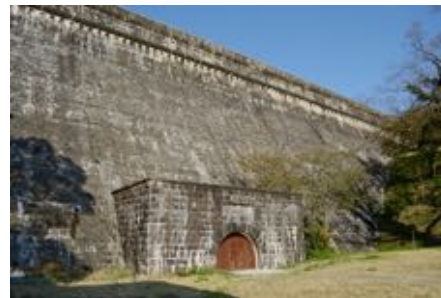
本河内低部ダム 日本で2番目に古いコンクリートダム。
