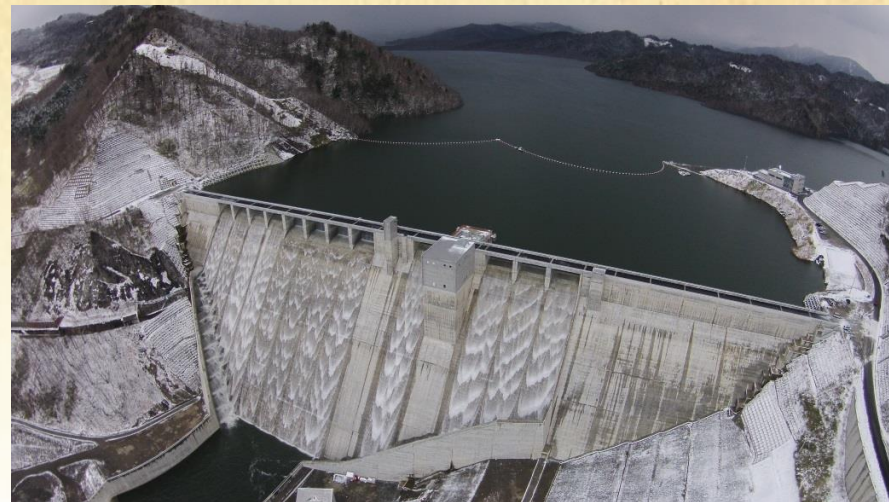
重力式コンクリートダム
