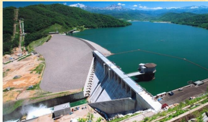
ダムは重力式コンクリートダムとフィルダムの複合ダム 忠別(ちゅうべつ)ダム (所在地: 北海道)
