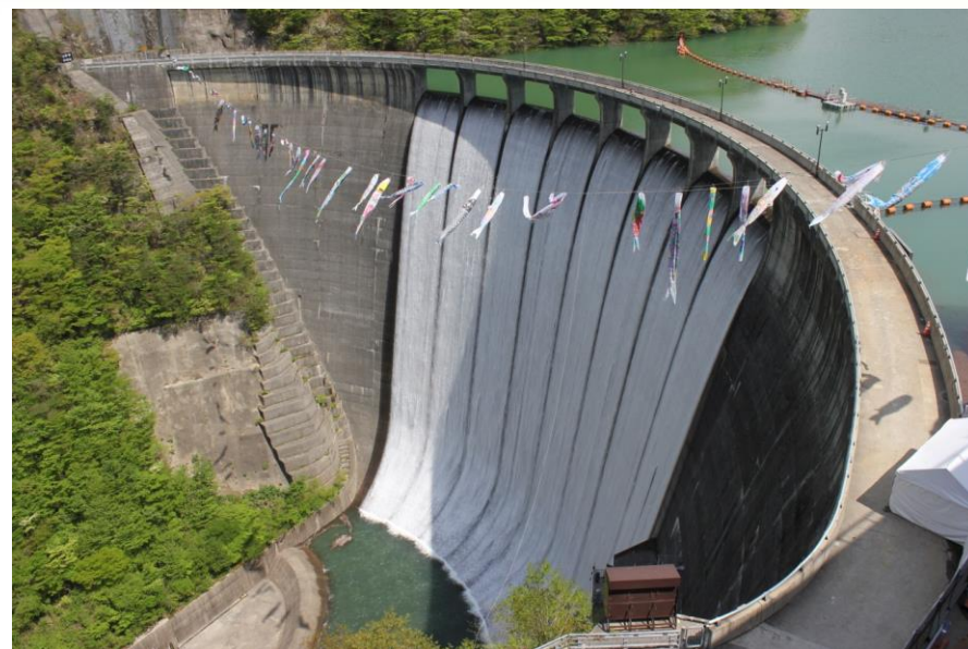
アーチ式コンクリートダム
