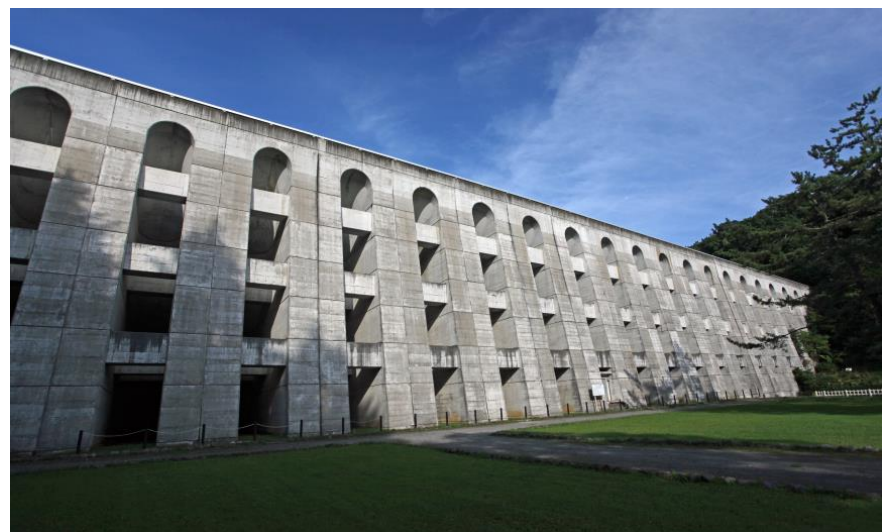
笹流(ささながれ)ダム(所在地: 北海道)はバットレスダム 写真提供: 萩原雅紀氏
