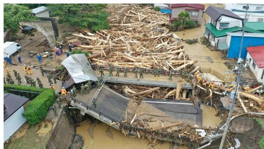
流木による橋梁箇所の閉塞被害
