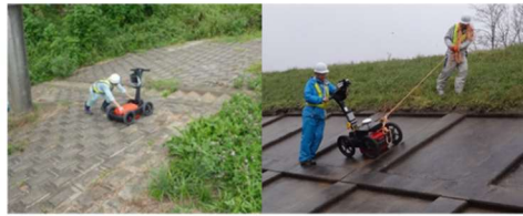
地中レーダ探査等非破壊検査
