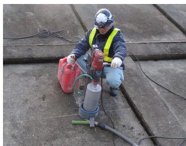
コアボーリングによる調査
