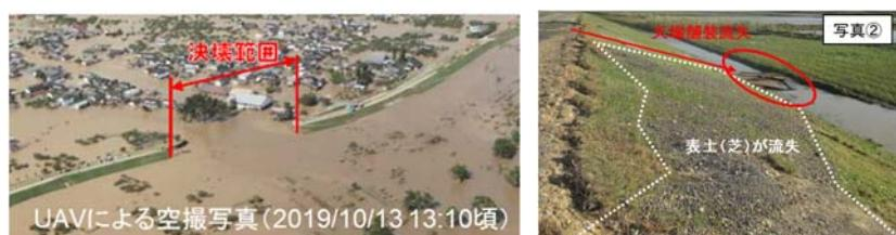
図-2 越水による決壊（千曲川）
