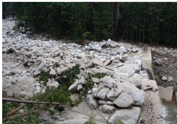
土石流の事例 (平成26年7月 長野県南木曾町 梨子沢)
