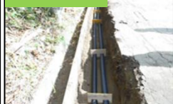
光ケーブル整備
